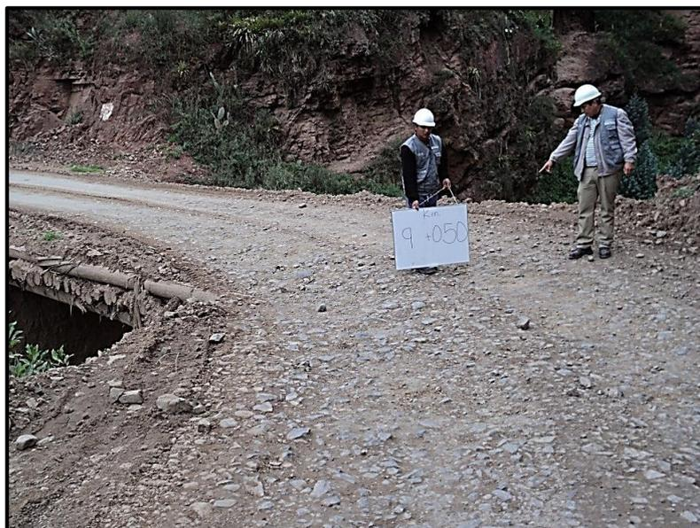
La rehabilitación de la carretera debiera ser con pavimento asfáltico, con cunetas de concreto y con obras de arte de concreto armado y/o modulares. **Fuente: Archivo personal.**
