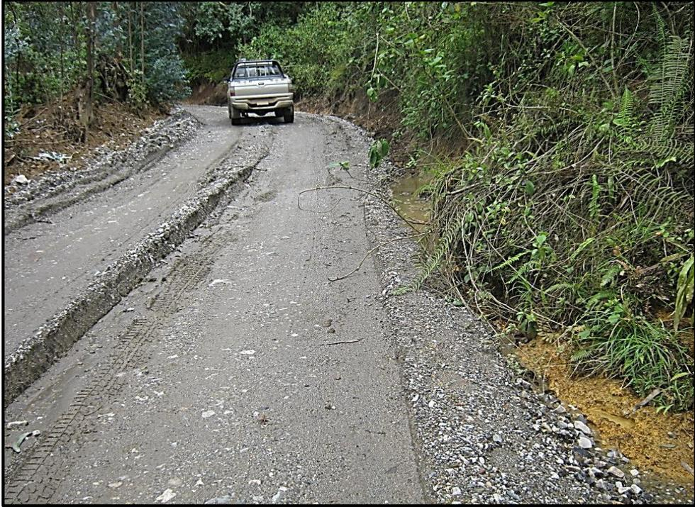
Estado actual de la superficie de rodadura a nivel de afirmado, se observa el deterioro de su estructura como ahuellamiento por falta de drenaje de aguas superficiales, deslizamiento de talud superior. Difícil que un pavimento sin una capa de protección pueda resistir los embates de la naturaleza. Se recomienda una pavimentación rígida. **Fuente: Archivo personal.**
