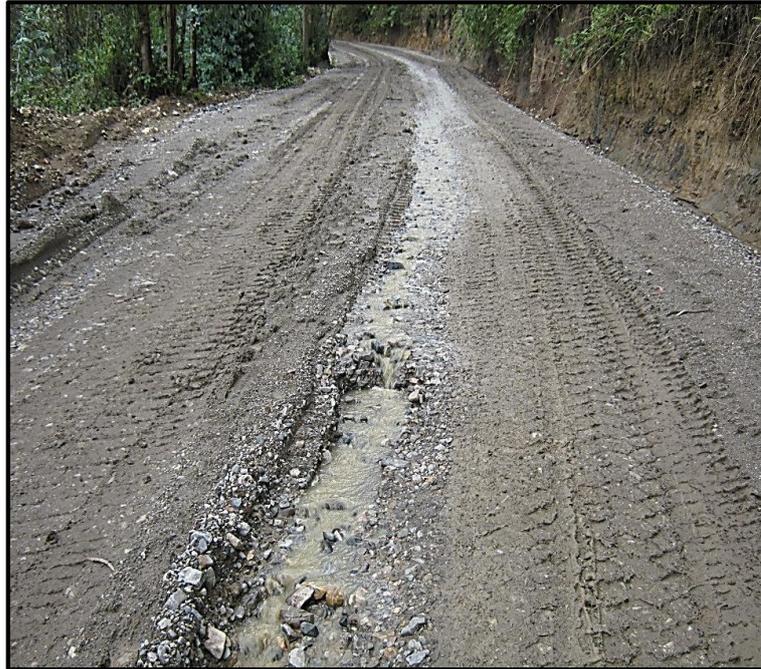
*Estado de la transitabilidad restringida debido a que la capa de afirmado ha sido erosionada por efectos del escurrimiento de aguas superficiales generadas por la presencia de lluvias, y por la falta de mantenimiento. Fuente: Archivo personal.*
