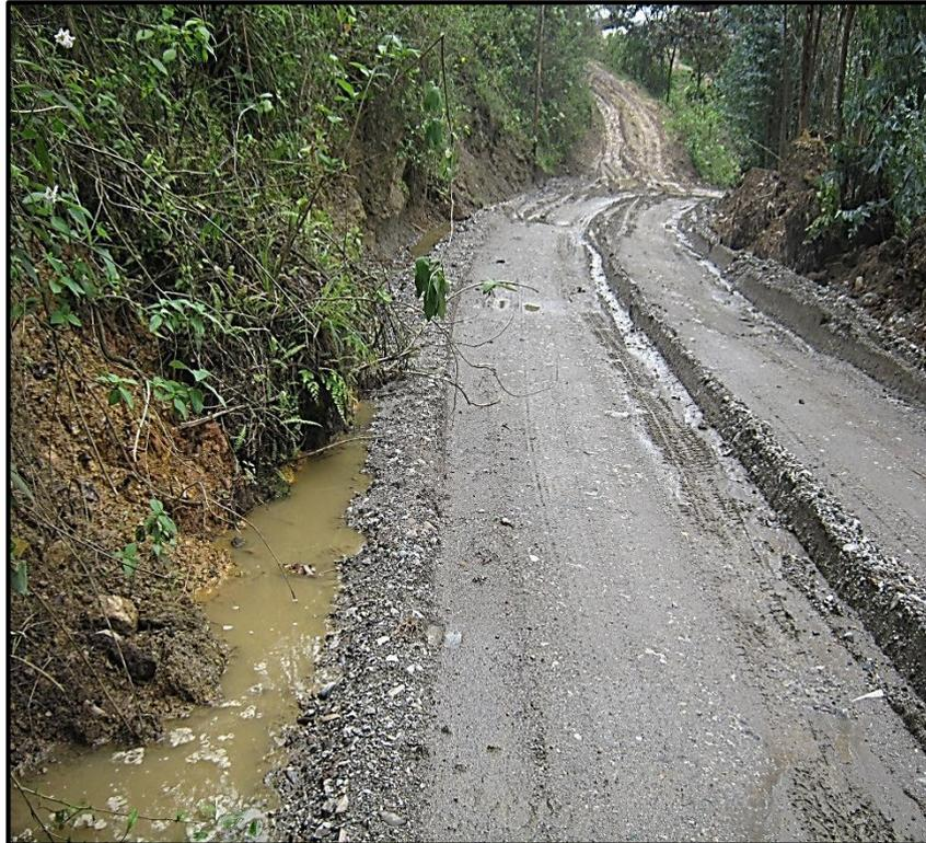
*Política del MTC en cuanto a la rehabilitación de carreteras de bajo Volumen de Tránsito señala que se debe utilizar como superficie de rodadura sólo a nivel de afirmado. Dicha política genera que las vías son potencialmente vulnerables a las lluvias tal como se observa ocasionando graves daños estructurales como ahuellamiento por falta de drenaje de aguas superficiales, debido a deslizamiento de talud superior, colmatando la sección hidráulica de la cuneta, por falta de mantenimiento, km.*
