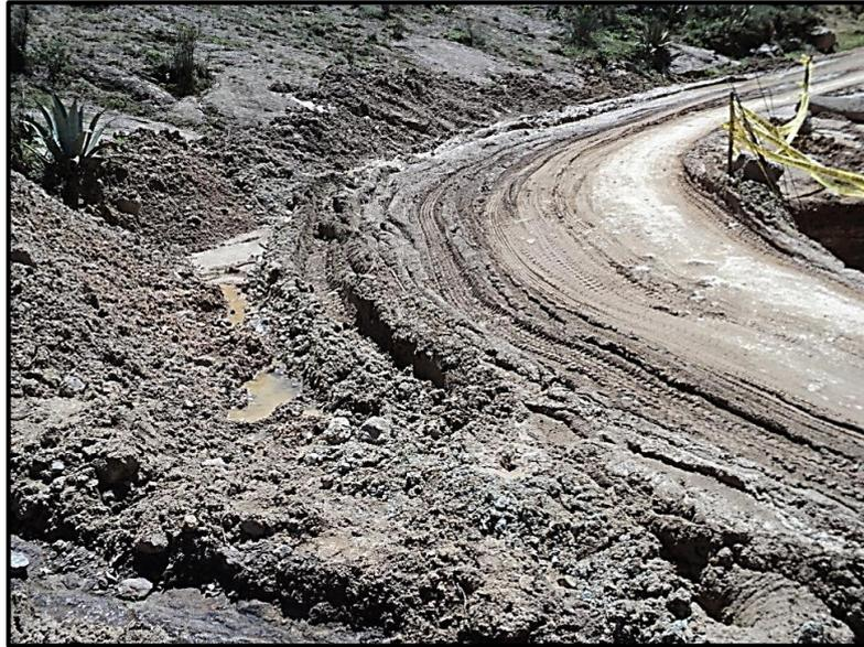
La pobre calidad de las canteras y la falta de tratamiento superficial capa de rodadura generan que el pavimento sufra gravemente en su estructura, disminuyendo niveles de servicialidad. **Fuente: Archivo personal.**
