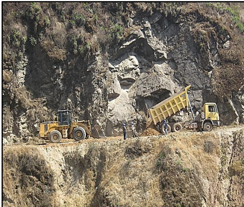
**Descarga y extendido de material de afirmado sobre la sub rasante, Km.**
