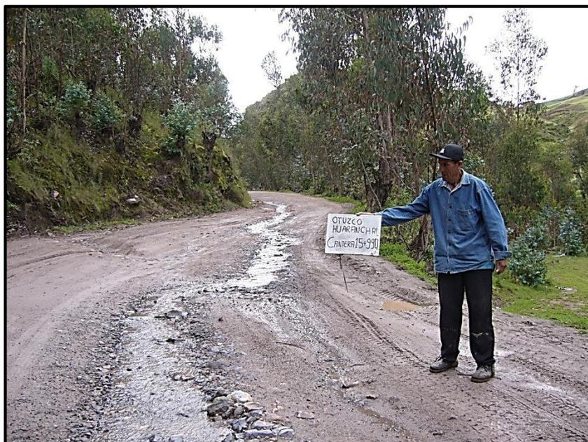
*Obsérvese que la capa de rodadura, prácticamente de suelo natural, con presencia predominante de materiales de granulometría fina, vale decir un suelo areno-limo-arcilloso, material que viene a ser un suelo fácilmente deleznable ante la presencia de aguas superficiales o pluviales. Prog. Km 15+990. Fuente: Archivo personal.*
