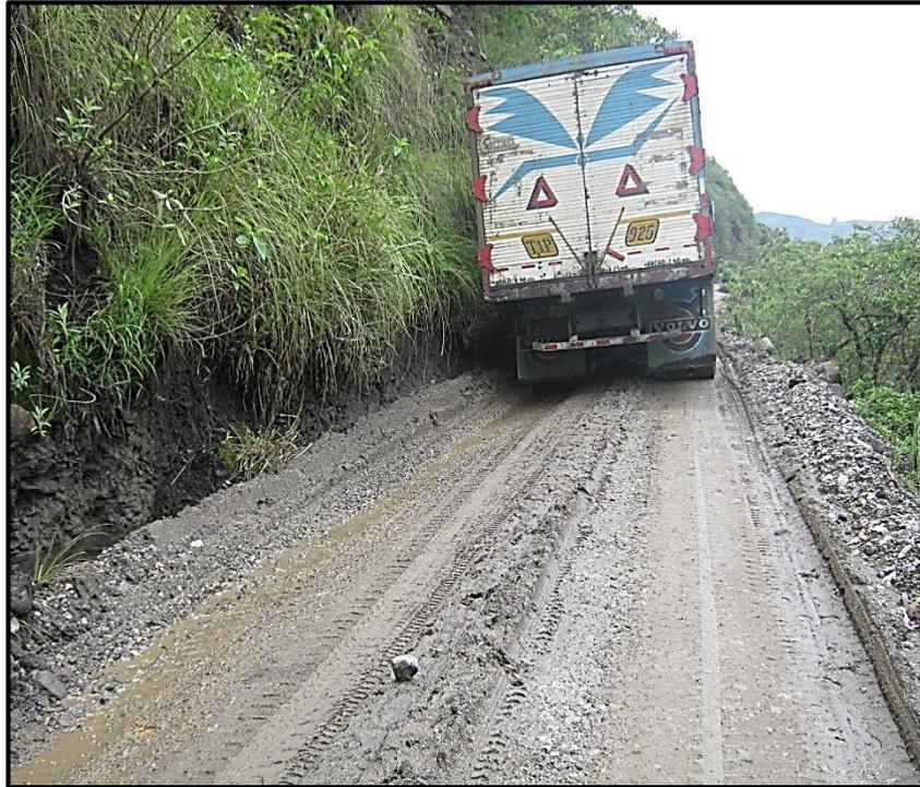
*Estado actual de la superficie de rodadura a nivel de afirmado, se observa la colmatacion de las cunetas con material de arrastre, requiere efectuar trabajos de mantenimiento. Nótese el paso de un camión de dos ejes. Los cuales generan un gran daño estructural. Fuente: Archivo personal.*
