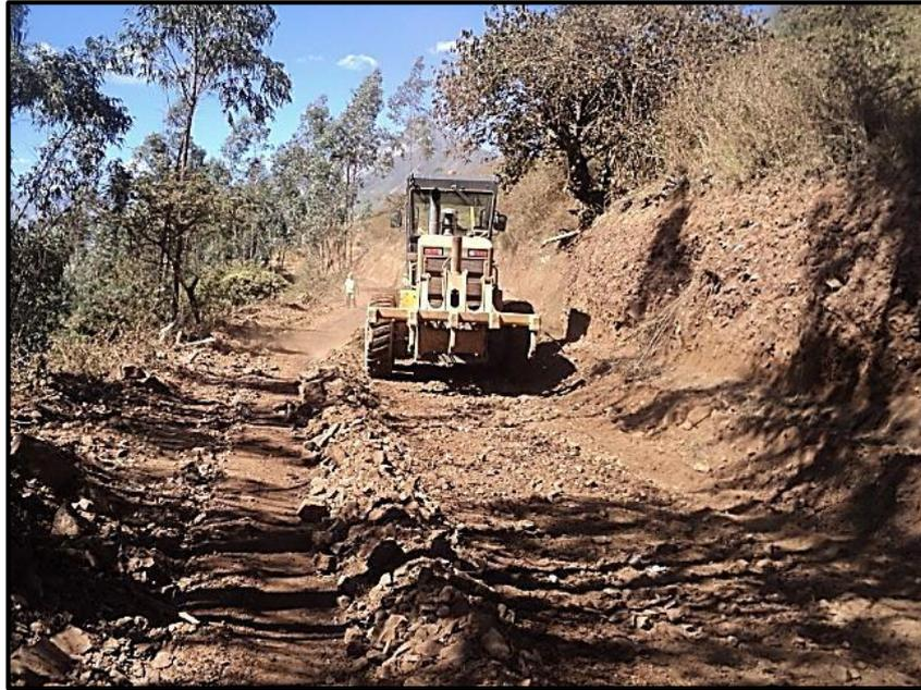
Proceso de extendido material granular del rio Alto Chicama. Nótese que a la mezcla aún le falta los componentes de material fino o liga para conformar adecuadamente la capa de afirmado. Trabajos entre las progresivas 58+000 y 57+000. **Fuente: Archivo personal.**
