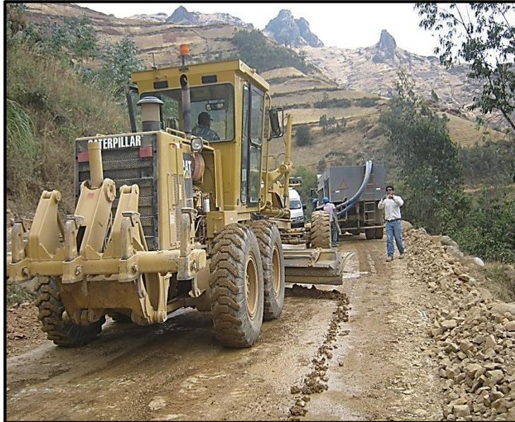
Motoniveladora efectuando los trabajos de refine de material de afirmado, Km. 33+400. **Fuente: Archivo personal.**
