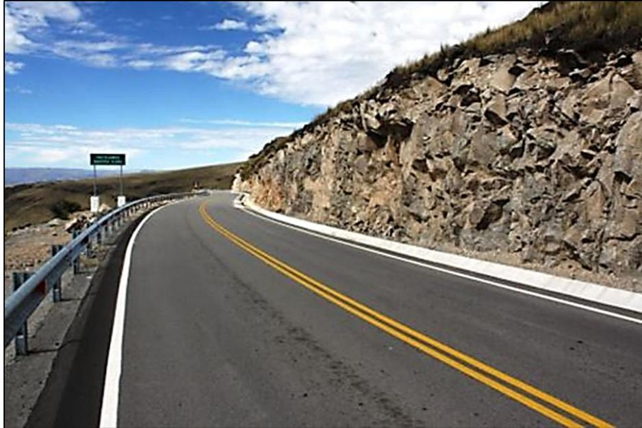
*Modelo de carretera a construirse en el tramo Otuzco-Usquil-Huaranchal con capa de rodadura de pavimento flexible de 2” como mínimo, cunetas de concreto y correctamente señalizadas.*
