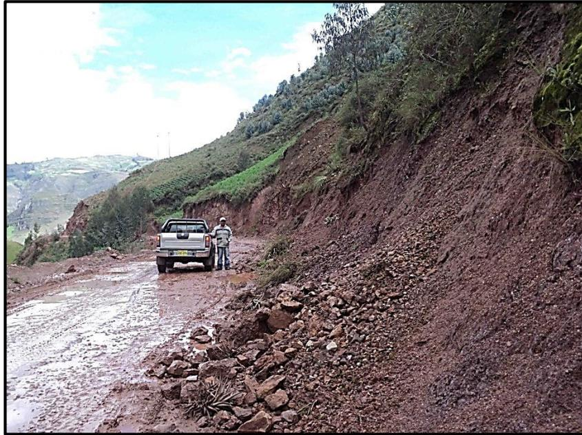
*Topografía muy accidentada de la carretera Otuzco-Usquil-Huaranchal que se eleva por encima de los 2,000 m.s.n.m. que por efectos de lluvias intensas desestabilizan las laderas de los cerros, ocasionando derrumbes. Urge modificación de reglamento de Vías de Bajo Volumen de Tránsito y mayor mantenimiento. Fuente:*
