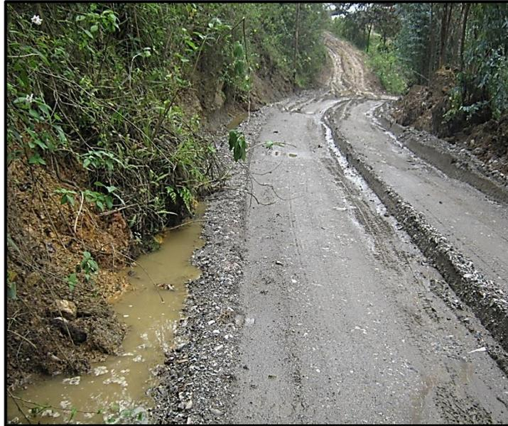
Se observa que la capa de rodadura es de material Afirmado, deformado por el tránsito de camiones pesados, una clara muestra de la falta de estabilidad y durabilidad de la vía.
