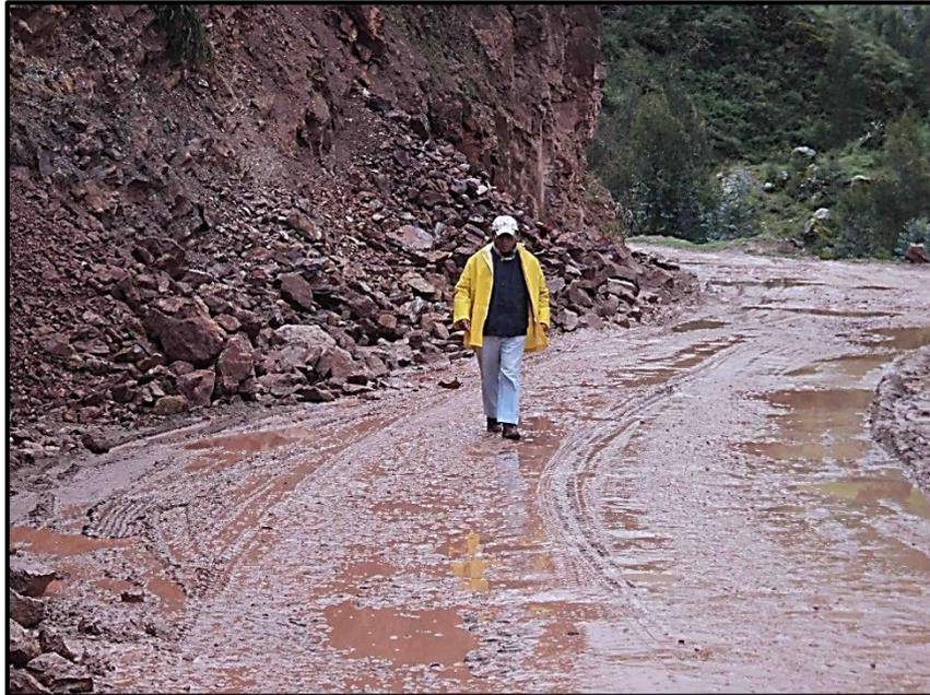
*El suscrito, Jefe de Supervisión de la Rehabilitación de la Carretera Otuzco-Usquil-Huaranchal, verificando los daños ocasionados por las lluvias intensas que saturaron la capa de afirmado, deteriorándola rápidamente. Fuente: Archivo personal.*
