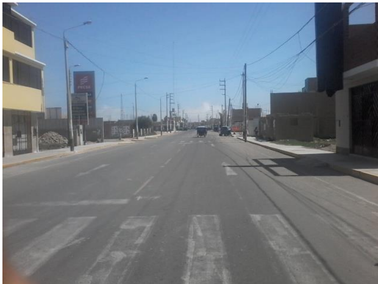
Vista Fotográfica de poste de media tensión eléctrica invadiendo el derecho de vía
