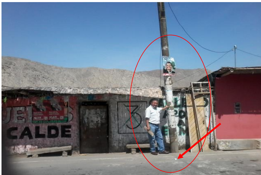
Vista Fotográfica de Poste Eléctrico invadiendo el derecho de vía
