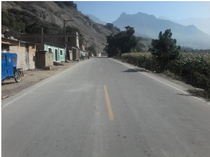
Figura N° 17: Vista Fotográfica inicial de Vivienda Urbana Km. 794+297
