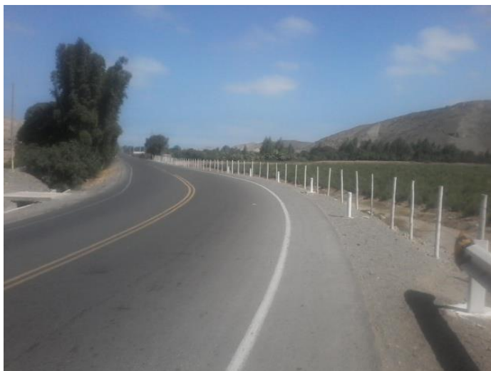
Figura N° 19: Vista Fotográfica de Poste Eléctrico Km. 783+977
