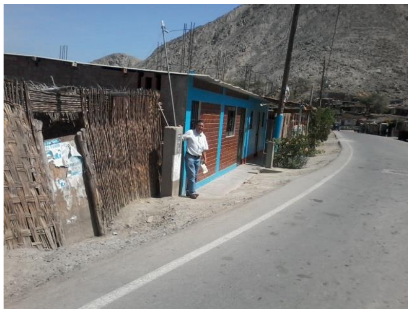
Vista Fotográfica de vivienda rural dentro el derecho de vía
