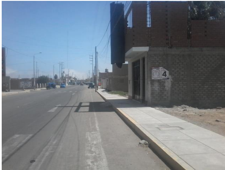
Vista Fotográfica final de Vivienda Rural
