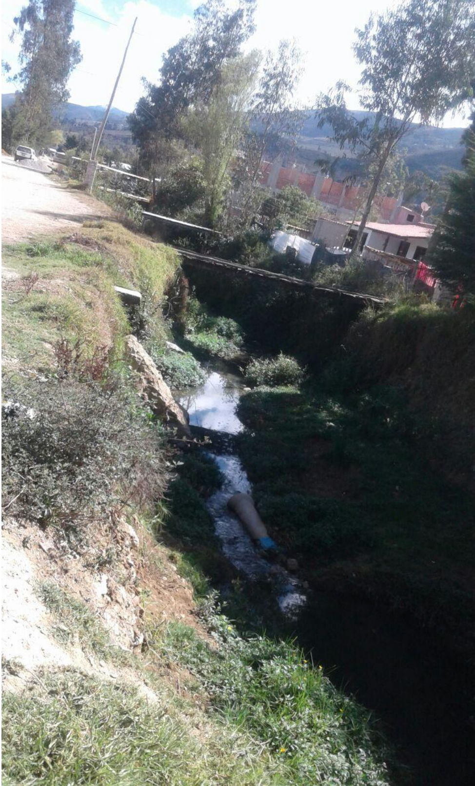
Fotografía N° 05: Cuadra N° 09 Jr. Pedro Ortiz Montoya, se puede apreciar que las viviendas están al borde del cauce.
