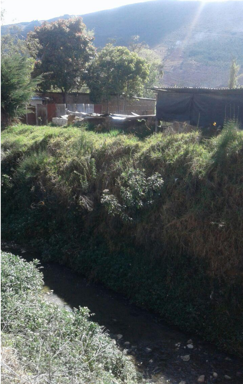
Fotografía N° 03: Cuadra N° 08 Jr. Pedro Ortiz Montoya, se aprecia viviendas destruidas por la última inundación registrada.
