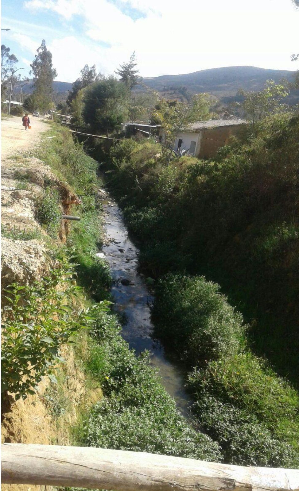
Fotografía N° 01: Cuadra N° 06 Jr. Pedro Ortiz Montoya, se aprecia mucha vegetación en el cauce del rio chico
