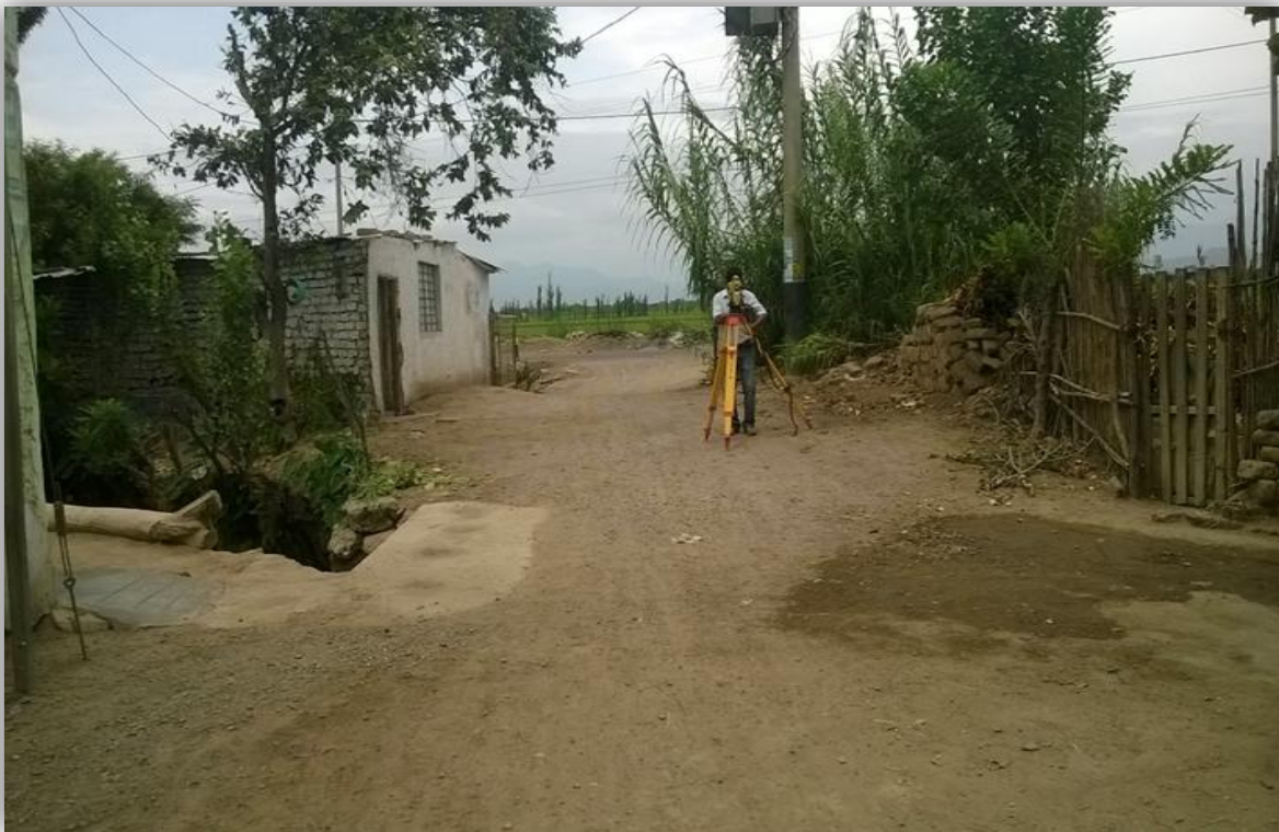
TOMA 04: LEVANTAMIENTO TOPOGRAFICO DE LA ZONA DE ESTUDIO. EQUIPO EMPLEADO: ESTACION TOTAL TOPCOM.
