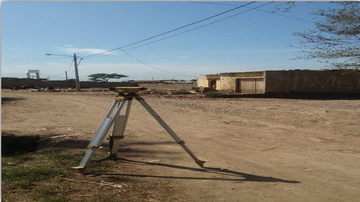
TOMA 03: CALIBRACION Y POSICIONAMIENTO DEL EQUIPO TOPOGRAFICO.
