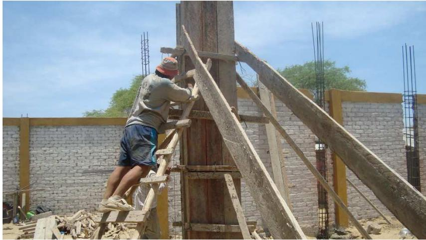
*Foto N° 03.* Vista de encofrado de columna aporticada de puesto de salud. Se aprecia el trabajo contributivo de aplomado de encofrado.
