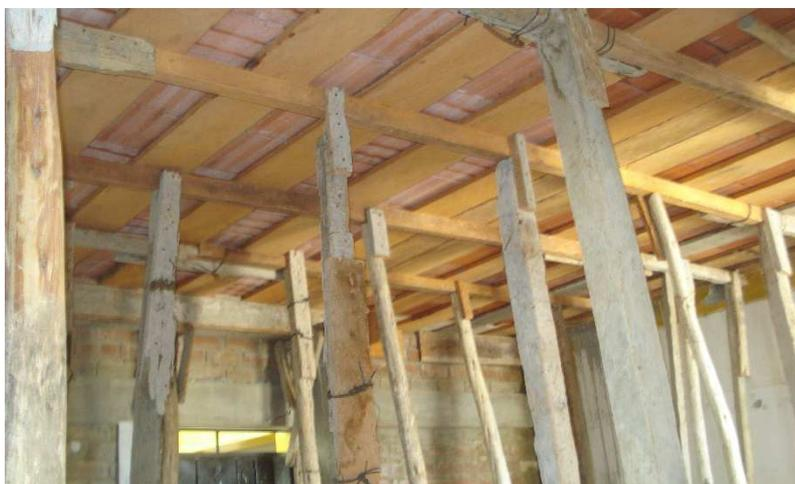
*Foto N° 08.* Vista interior de encofrado de techo. La colocación del pie derecho de apoyo, constituye un trabajo contributivo.
