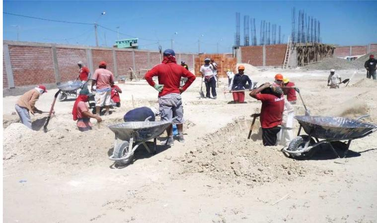
Foto N° 09. Excavación de zanjas para cimentación en bloque del nivel inicial. Se aprecian los tres tipos de trabajo: productivo los que están excavando, contributivo los que llevan la carretilla y no contributivo los que no hacen nada o están simplemente observando.
