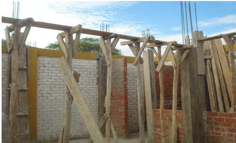
*Foto N° 06.* Trabajos de encofrado en vigas peraltadas.
