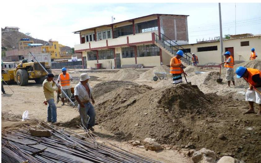
*Foto N° 18.* Trabajos de excavación de zanjas para cimentación. Mucho del personal obrero esta realizando trabajos no contributivos al solo mirar y tomar descansos en muchos intervalos.
