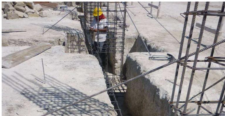
Foto N° 10. Habilitación de acero en zapatas y columnas del pabellón de inicial. El obrero esta ejerciendo un trabajo productivo.
