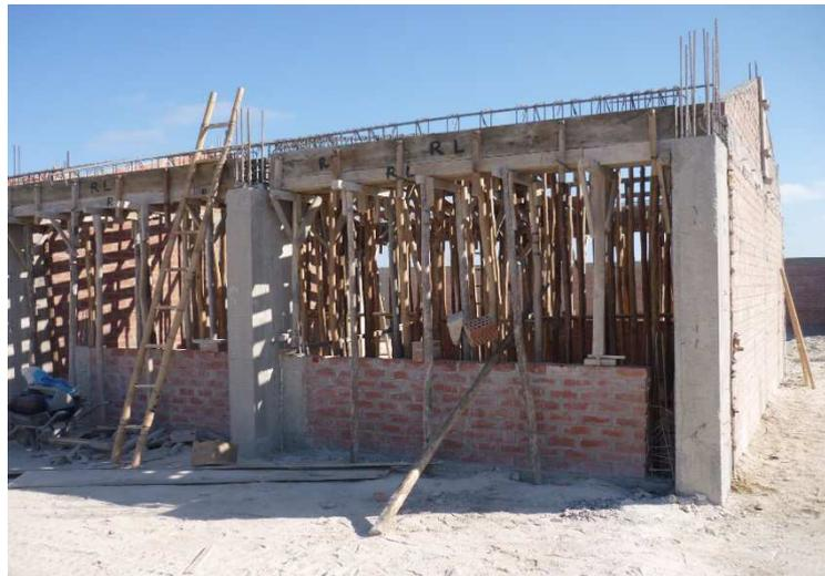
*Foto N° 15.* Ejecución de partidas de encofrado de vigas y losa aligerada en pabellón inicial.
