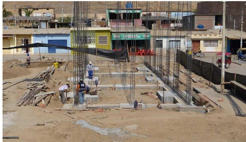
*Foto N° 20.* Trabajos de habilitación de acero en Sobrecimientos en pabellón de obra. El personal mostrado realiza trabajos del tipo productivo.
