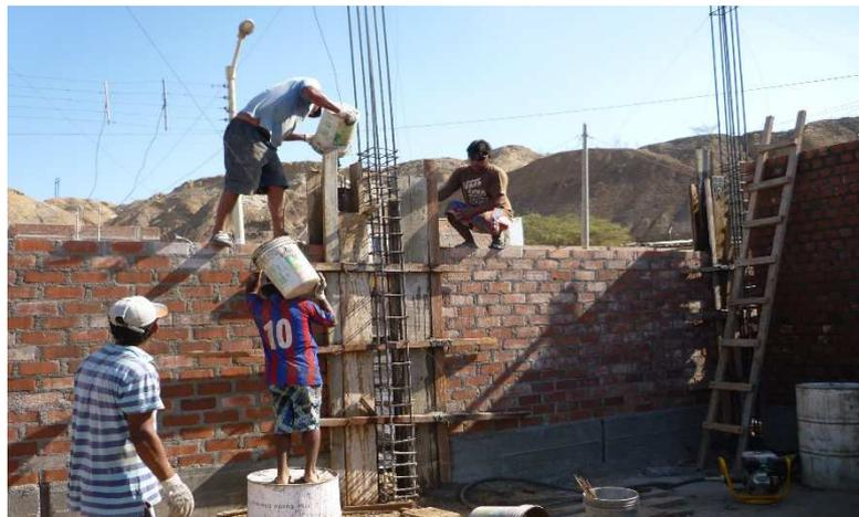
*Foto N° 24.* Vaciado de concreto en columnas de confinamiento en salón de usos múltiples. El obrero que vierte el concreto hace un trabajo productivo, el que lleva el concreto hace un trabajo contributivo y los que solo observan, realizan un trabajo no contributivo.
