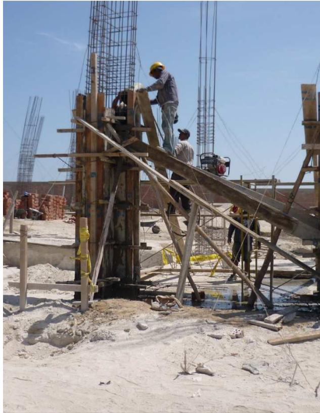
*Foto N° 12.* Trabajo de vaciado de concreto en columnas en bloque del nivel inicial. El obrero que vierte el concreto realiza un trabajo productivo. Los que alcanzan las latas concreteras, realizan un trabajo contributivo, y el que al fondo espera, un trabajo no contributivo.
