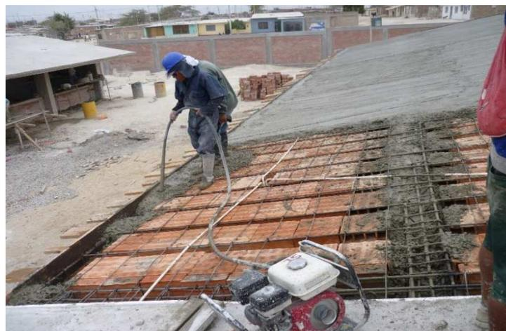
*Foto N° 16.* Vista de vaciado de concreto en vigas y losa aligerada del bloque inicial.
