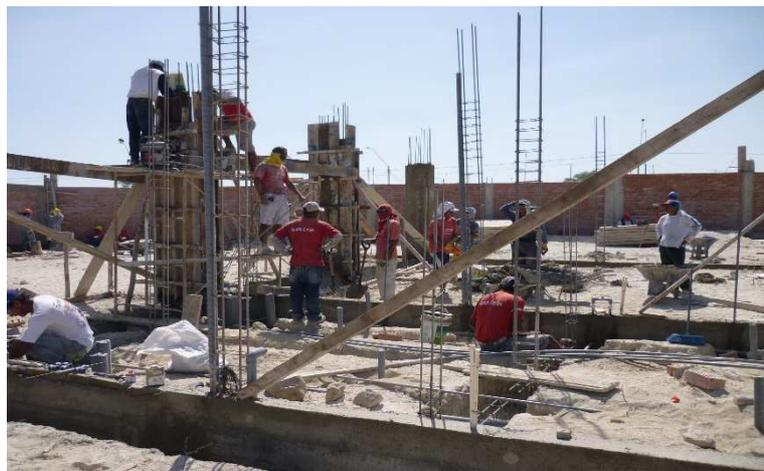
Foto N° 11. Ejecución de partida de concreto en columnas en bloque del nivel inicial. Al igual que en la foto N°09, se aprecian los tres tipos de trabajos.
