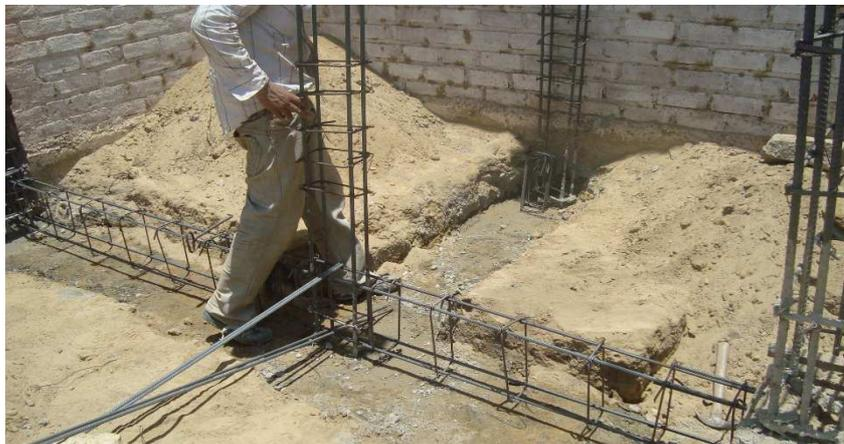
*Foto N° 04.* Vista de habilitación de acero en columnas y sobrecimientos. Para este caso se necesita el trabajo contributivo de limpieza para trazado sobre el cemento
