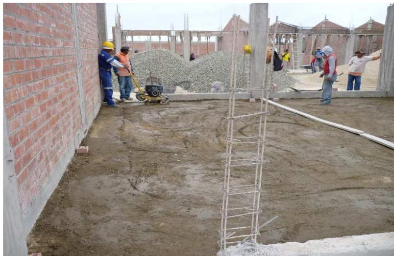
*Foto N° 13.* Trabajos de relleno y compactado en bloque del nivel inicial. El operario con el planchador realiza un trabajo productivo, mientras que el obrero de su costado un trabajo no contributivo (mirar).
