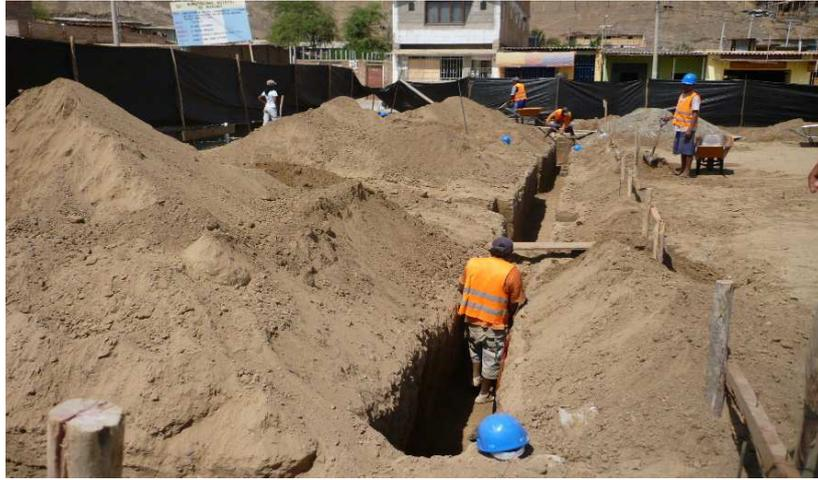
*Foto N° 19.* Otra vista de excavaciones de zanjas. El obrero dentro de la zanja realiza un trabajo productivo, mientras que el del lado derecho un trabajo contributivo al acarrear el material excedente.
