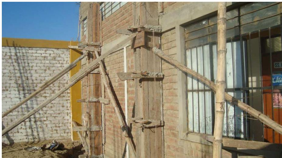
*Foto N° 02.* Columna aporticada encofrada y vaciada, adyacente a edificación existente. Para la ejecución de esta partida se nesito del trabajo contributivo de corte y colocación de tecnopor
