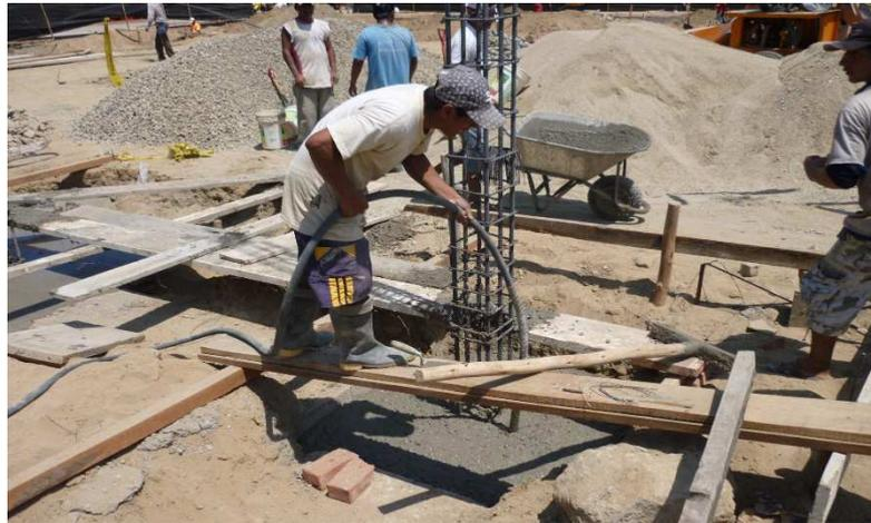
*Foto N° 23.* Actividad contributiva de vibración para concreto en zapatas.
