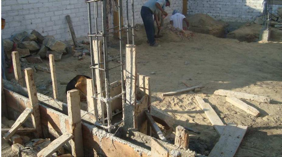
*Foto N° 01.* Vista de sobrecimiento encofrado y vaciado en primer plano, apreciándose en el fondo trabajos contributivos de excavación de zanjas.
