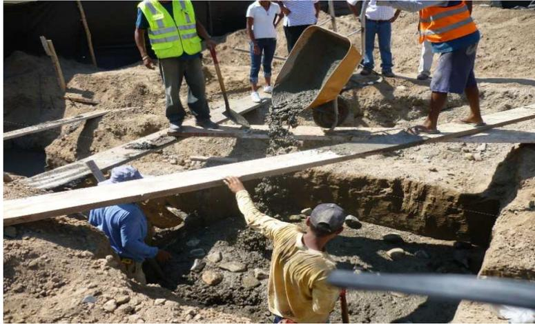
*Foto N° 22.* Trabajos de vaciado de concreto en zapatas. El personal ubicado dentro de la zanja realiza el chuseado del concreto (trabajo contributivo), mientras que el que vierte el concreto hace el trabajo productivo, los demás realizan un trabajo no contributivo al solo mirar.
