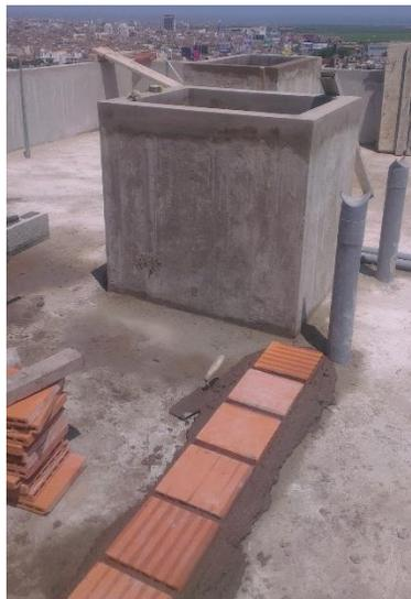
*Ilustración 90. Inicio de colocación de ladrillo pastelero en último techo. Fuente: Elaboración Propia*
