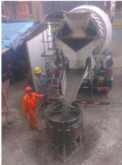
*Ilustración 88. Carguío del balde concretero. Fuente: Elaboración Propia*
