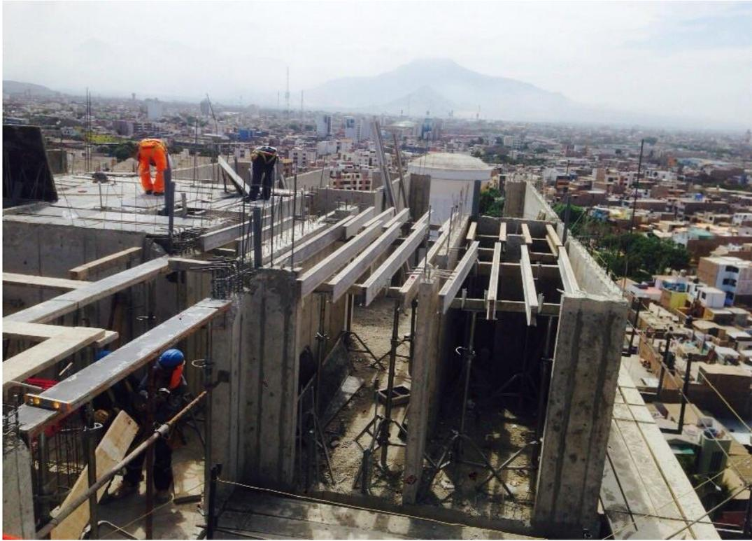
*Ilustración 81. Apuntalamiento de estructura de losa. Fuente: Elaboración Propia*
