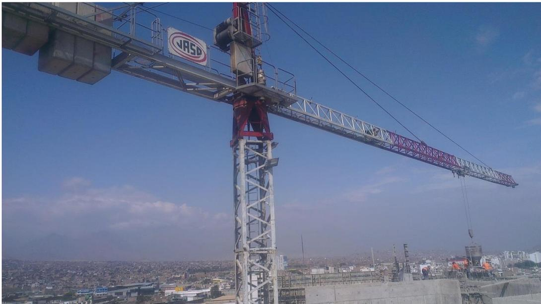
*Ilustración 82. Colocación de concreto con torre-grúa. Fuente: Elaboración Propia*
