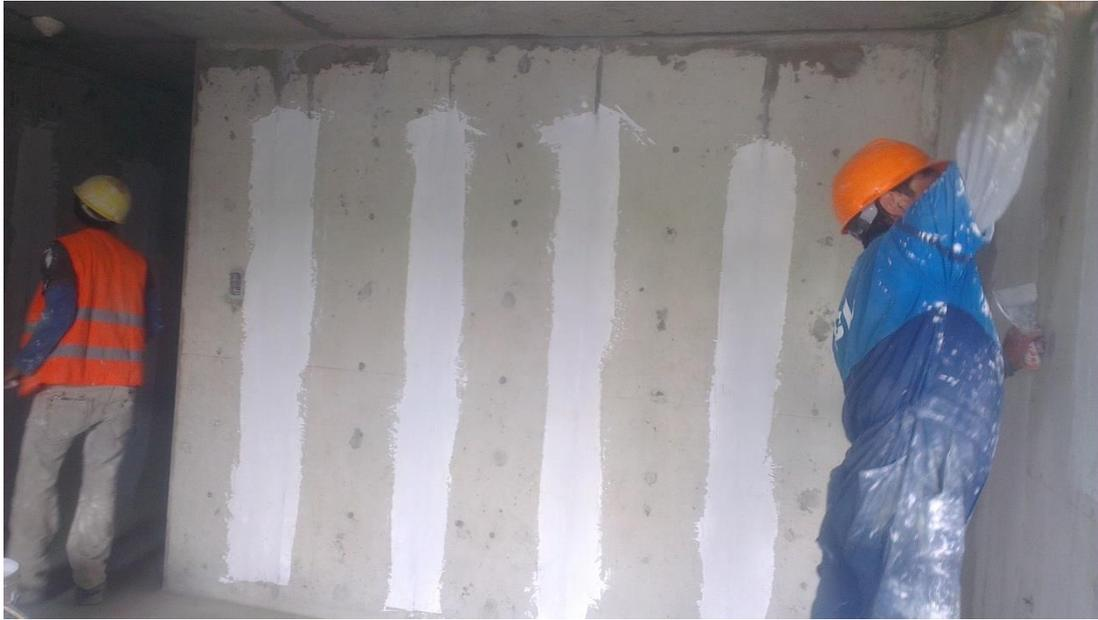
*Ilustración 91. Inicio de trabajos de pintura – enyesado de juntas del encofrado metálico. Fuente: Elaboración Propia*
