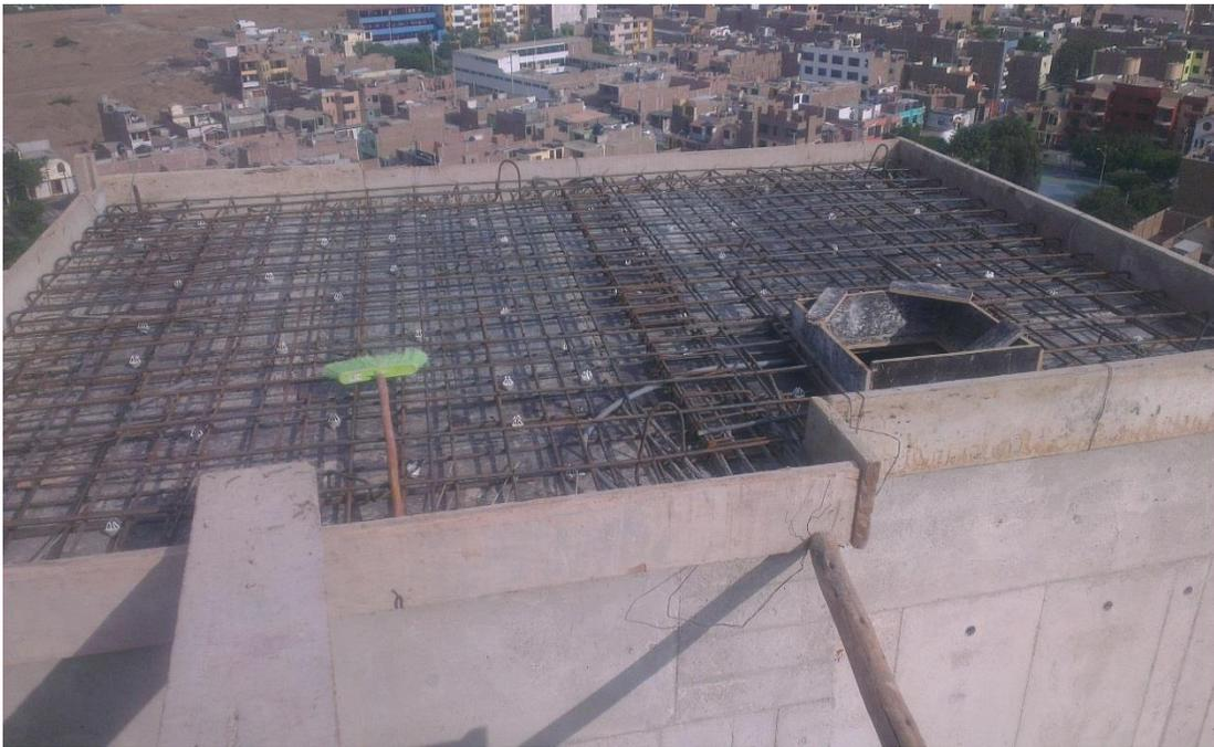
*Ilustración 84. Techo de tanque elevado previo al vaciado. Fuente: Elaboración Propia*
