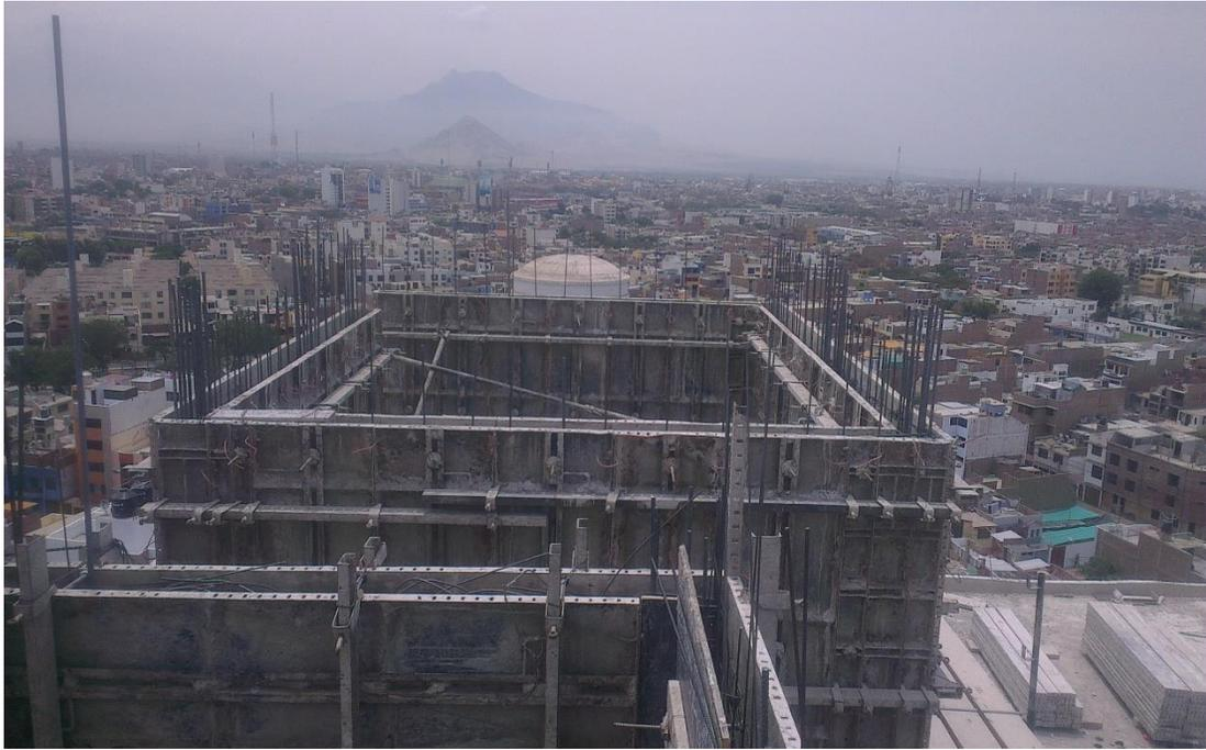
*Ilustración 83. Encofrado de muros de cisterna y cuarto de máquinas. Fuente: Elaboración Propia*
