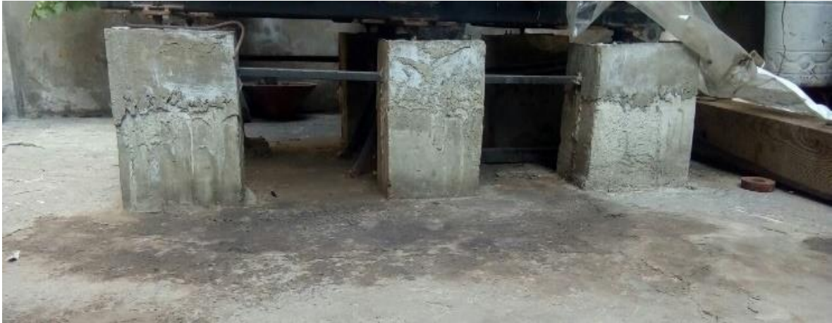
Fuente: Propia – Pilares desencofrados y terminados.
