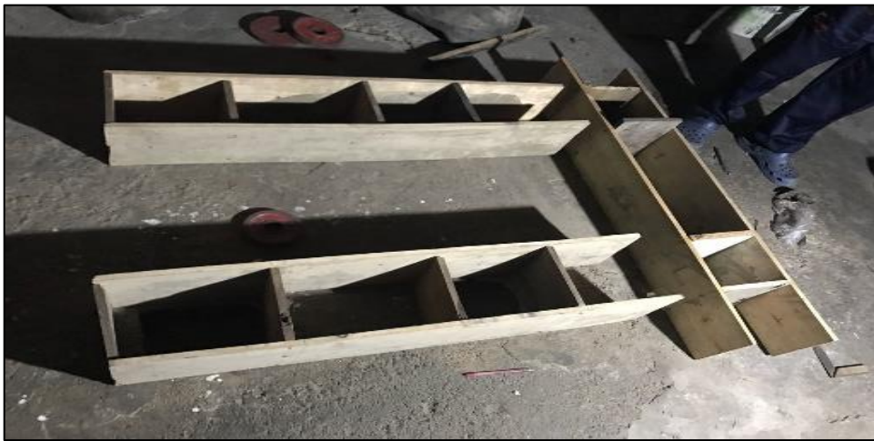
Fuente: Propia – Montaje de encofrado de madera para pilares.
