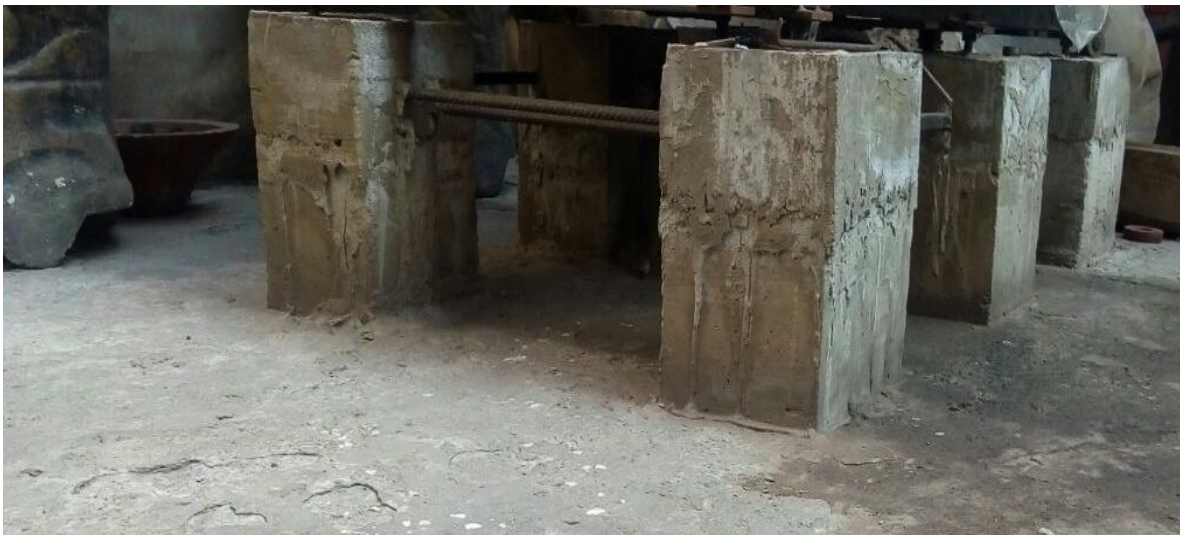
Fuente: Propia – Pilares desencofrados y terminados.
