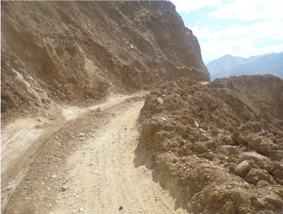
Foto N° 1:- Tramo de la vía donde el terreno es tipo Material Suelto.
