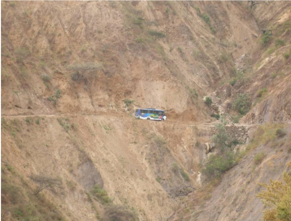
Foto N° 11:- Muro seco existente en una quebrada donde se proyectada un Badén.
