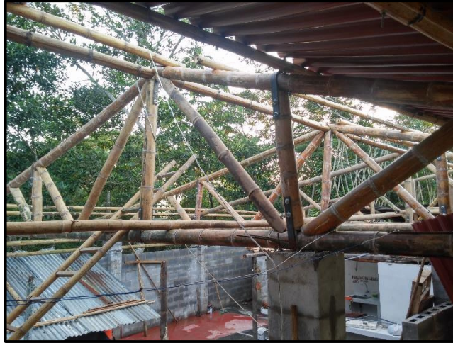
IMAGEN N° 2. Autoconstrucción con bambú en Moyobamba.
