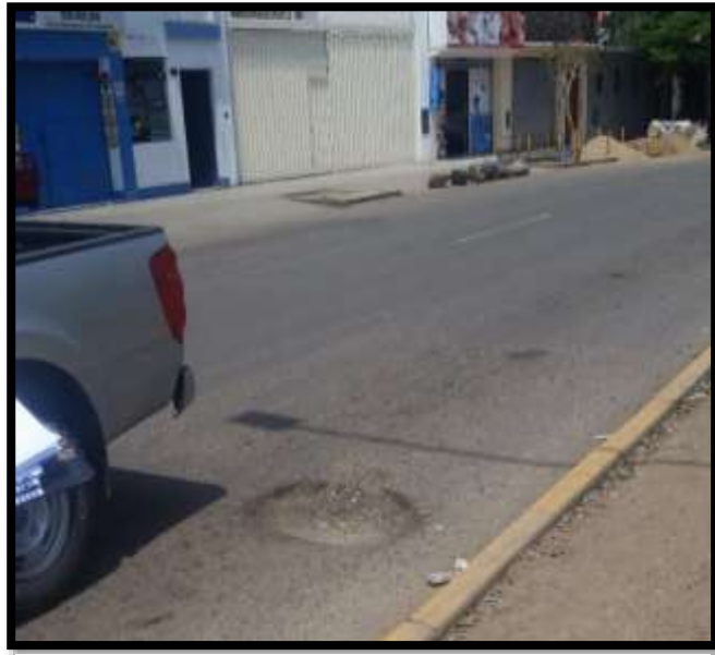
Figura 43: Estado de vía
