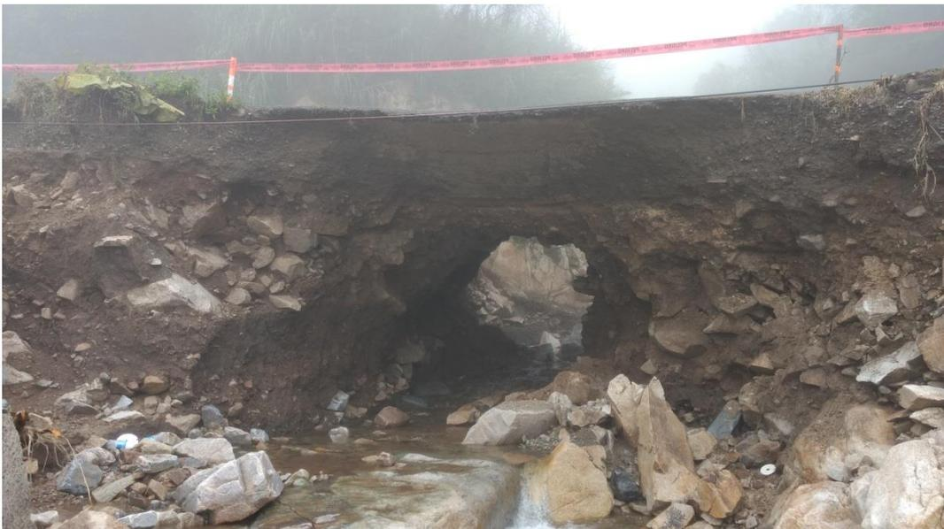
*Fotografía 2. Vista de con dirección aguas arriba, se observa la pérdida del tubo de la alcantarilla TMC*
