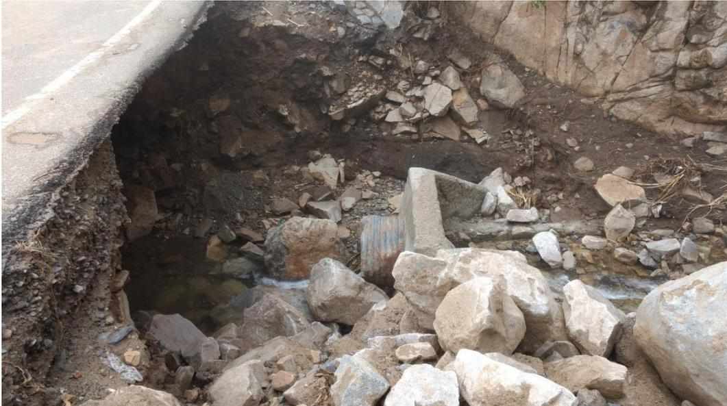
Fotografía 3. Vista de la salida de la alcantarilla, se observa la pérdida del cabezal de salida.
