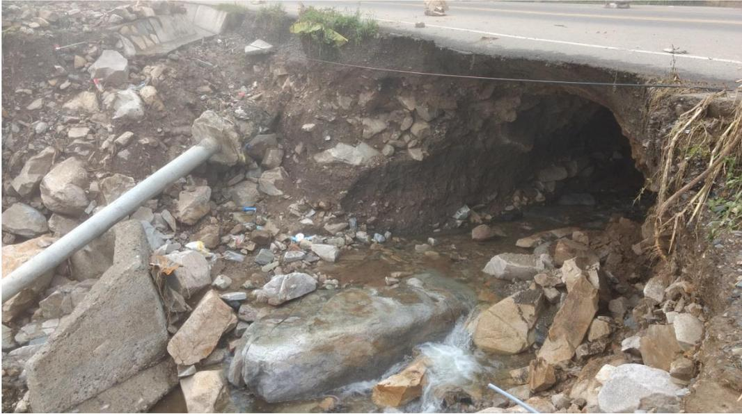
*Fotografía 1. Salida de la alcantarilla, se observa le pérdida del cabezal.*
