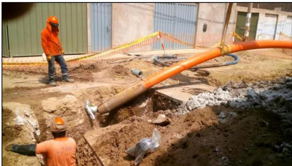
**Figura N° 30: Fragmentación y jalado de tubería nueva.
