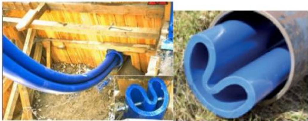
**Figura N° 11: Tubería doblada en “U”, siendo colocada.
