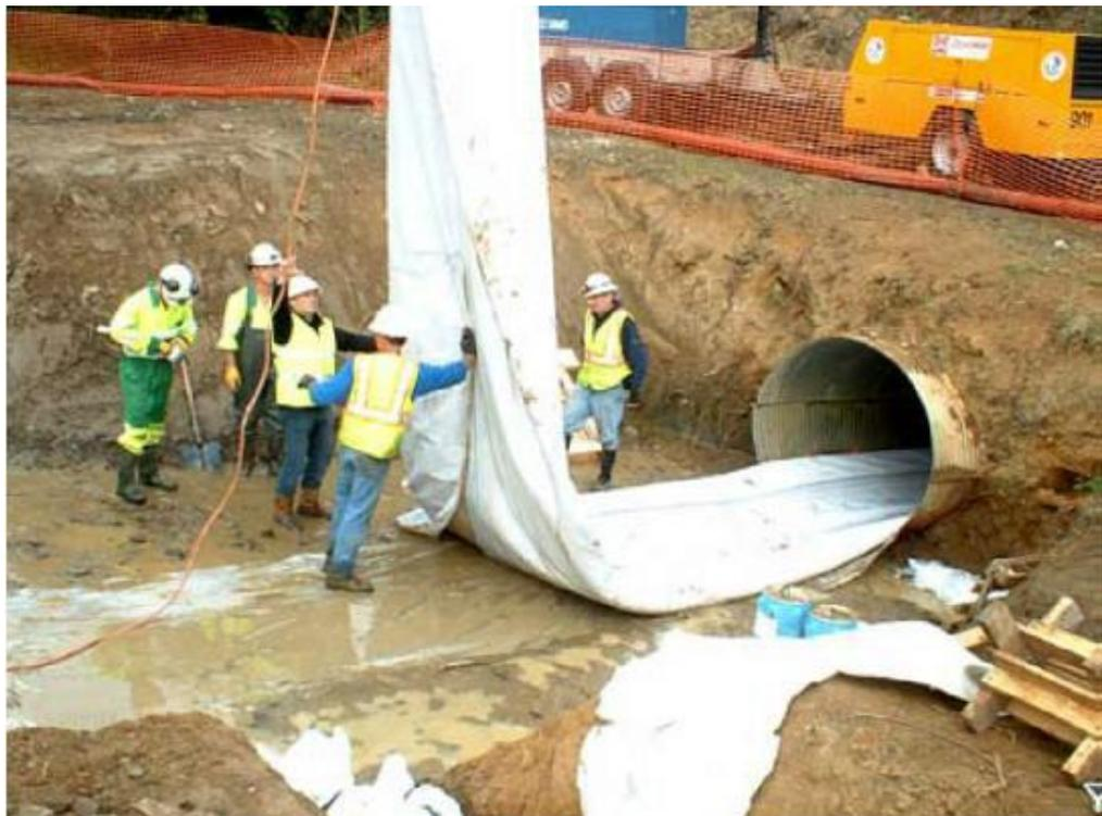
**Figura N° 09: Colocación del polímero en la tubería para su posterior puesta en servicio.**
