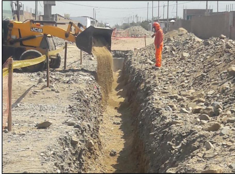
**Figura N° 19: Colocación de cama de apoyo**
