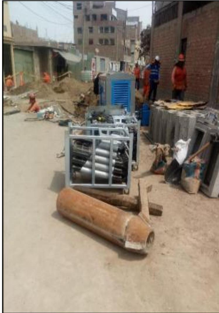
**Figura N° 28: Fragmentador y Cabezal de roti.
