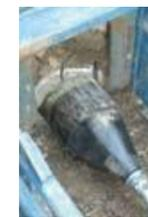
La tubería nueva está ceñida a la pared de la tubería vieja.
