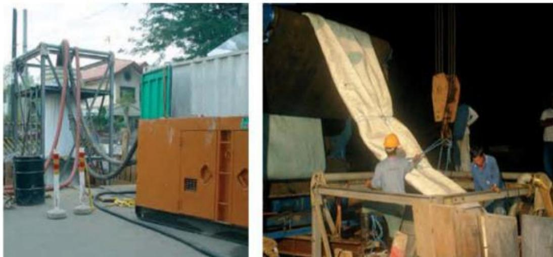
**Figura N° 10: Maquinaria utilizada para la colocación de la tubería de poliéster en obra.**
