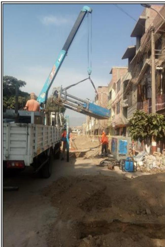
**Figura N° 26: Traslado del equipo fragmentador.
