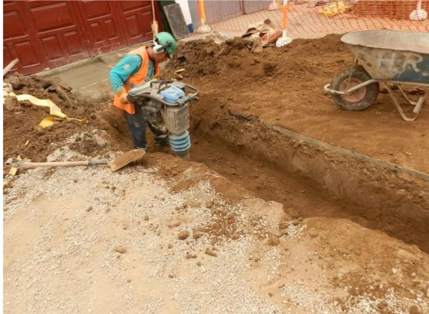
**Figura Nº 21: Trabajos de compactación de zanja**
