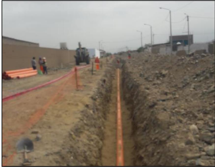
**Figura N° 20: Colocación de tubería**
