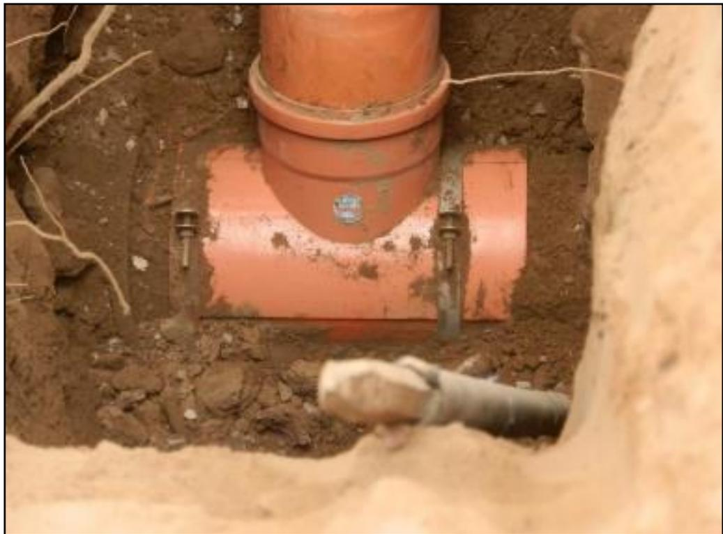
**Figura N° 32: Acoplamiento de accesorio domiciliario con abrazaderas.
