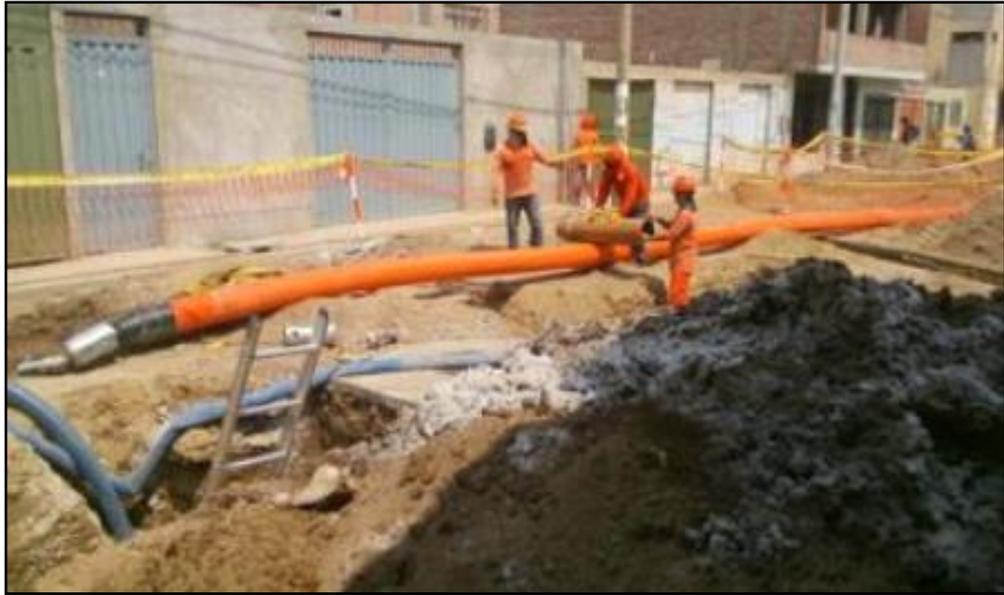
**Figura N° 34: Ejecución de obra por el método Cracking.
