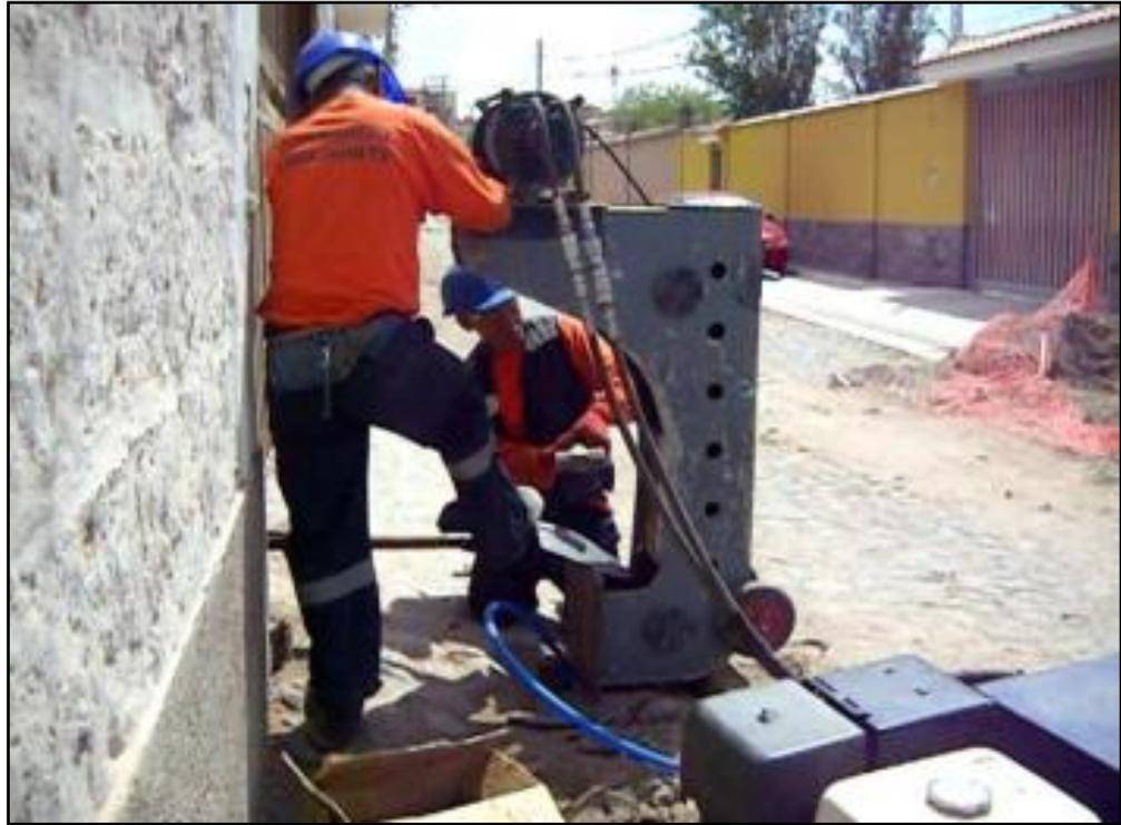
**Figura N° 31: Equipo de Fragmentación lateral.
