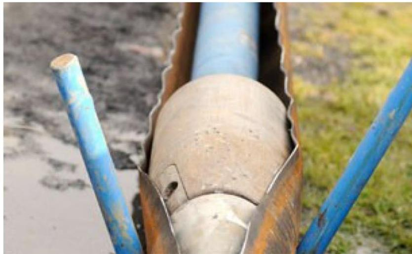
**Figura N° 05: Ejemplo de ampliador tipo cónico para la ruptura de tuberías, mientras se coloca al mismo tiempo la tubería nueva.**
