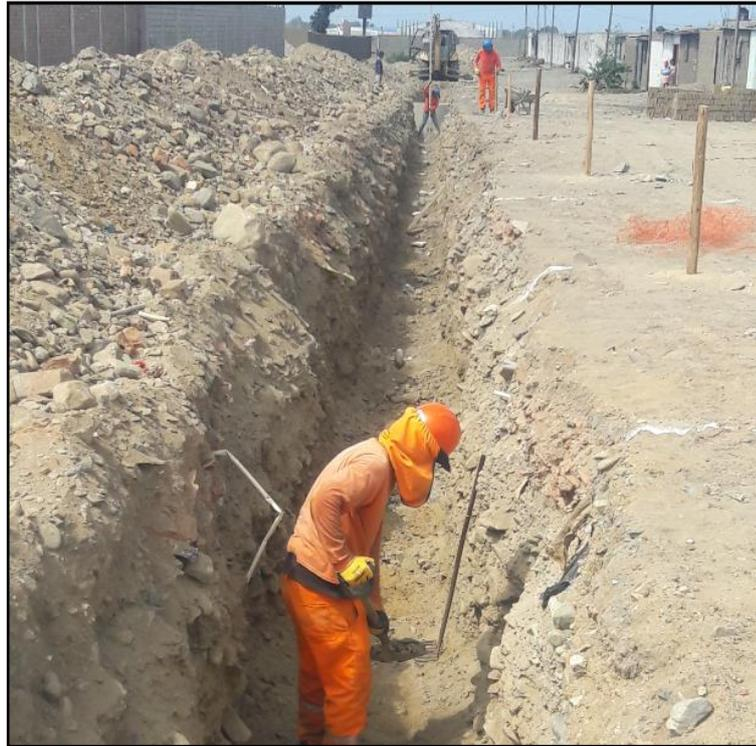
**Figura N° 18: Refine de zanja**
