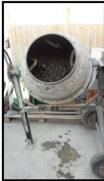
Imagen N° 06: se mantiene en movimiento el trompo por unos minutos
