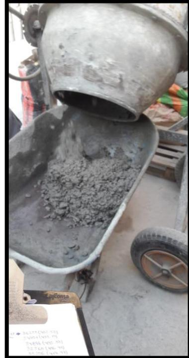
Imagen N° 07: luego de tener una mezcla uniforme se deposita en el bugy
