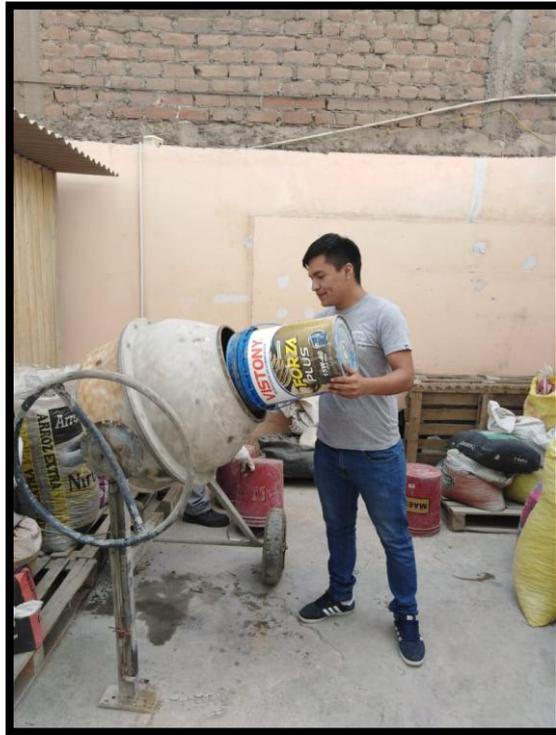
Imagen N° 05: se procede a poner todo el material al trompo para ser mezclado
