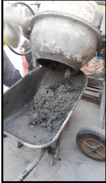
Imagen N° 08: luego de obtener una mezcla uniforme se deposita en un bugie
