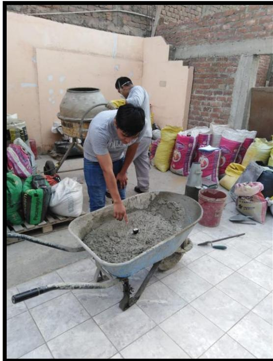
Imagen N° 08: se toma la temperatura al concreto fresco
