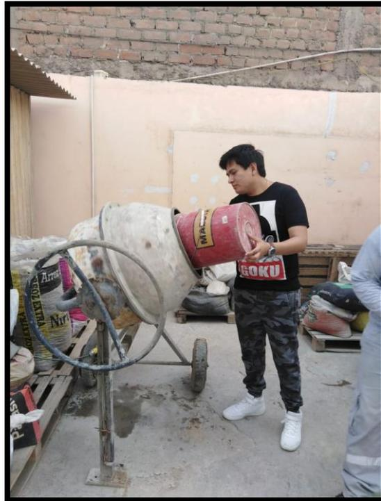
Imagen N° 06: se coloca los materiales en el trompo para ser mezclados
