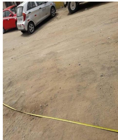
**DESPRENDIMIENTO DE AGREGADOS DE ALTA SEVERIDAD (H)**
