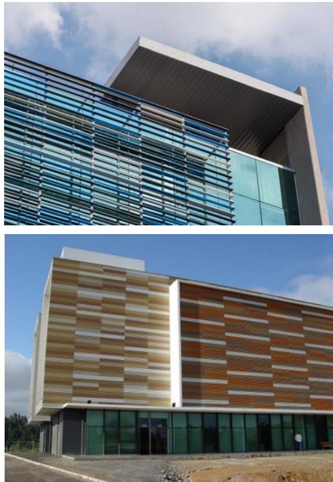
FIGURA N° 91: Instalación Quadrobrise 32 x 32 en fachadas
