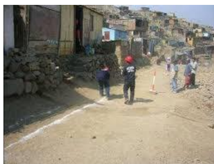
Fig. N° 11: Trazo y Replanteo de Red de Agua Potable
