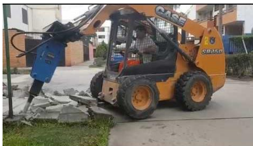
Fig. N° 12: Demolición de Veredas y Sardineles.
