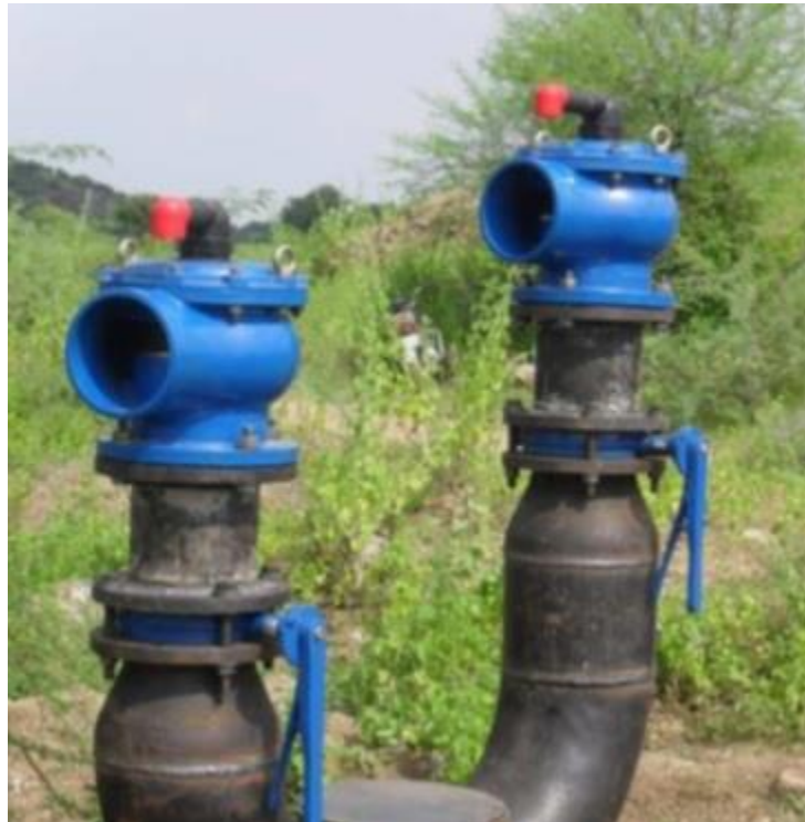
Fig. N° 8: Válvula de aire para control de presión negativa y positiva
