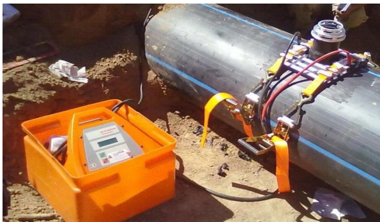
Fig. N° 18: Electrofusión en tuberías de agua potable
