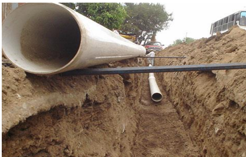
Fig. N° 15: Instalación de tubería a zanja abierta
