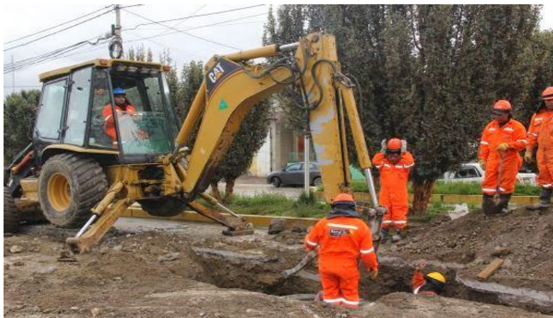
Fig. N° 13: Excavación de zanjas
