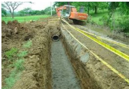
Fig. N° 17: Relleno de Zanja
