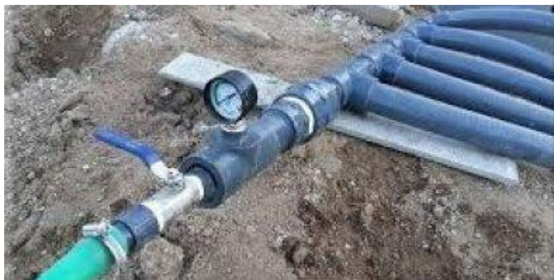
Fig. N° 16: Prueba Hidráulica y hermética en tubería de PVC
