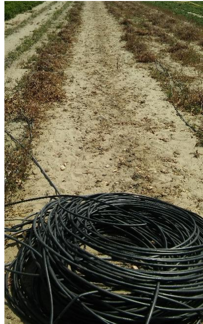
Figura 5. Instalación del nuevo lateral de riego
