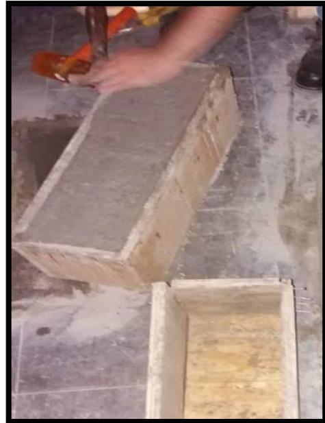
Figura N°. 21 y 22. Llenado y apisonamiento de concretos.
