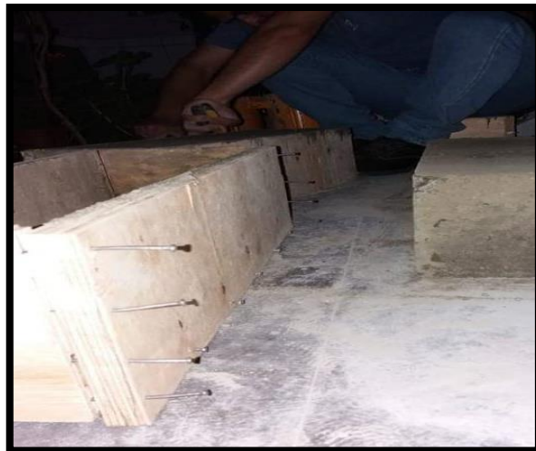
Figura N°. 23. Enrase de vigas.
