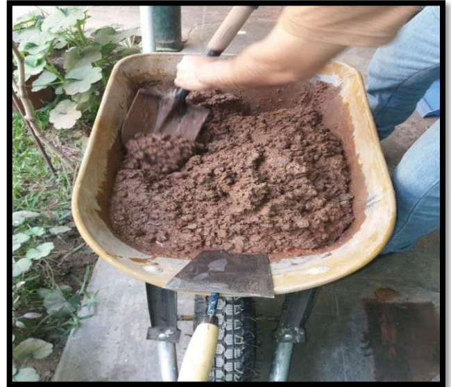
Mezclado del Concreto
