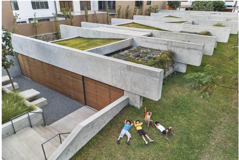
FOTOGRAFIA N° 57: Plaza Cultural Norte. Fuente: Plataforma Arquitectura Por: Ramiro Del Carpio
