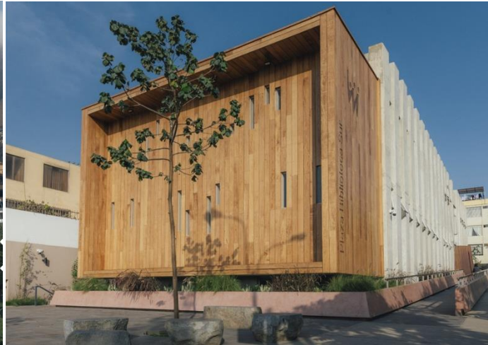
FOTOGRAFIA N° 54: Vista frontal - Plaza Biblioteca Sur Fuente: González Moix Arquitectura
