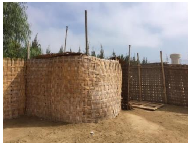
FOTOGRAFIA N°27: Cerco perimétrico de esteras Fuente: trabajo de campo
