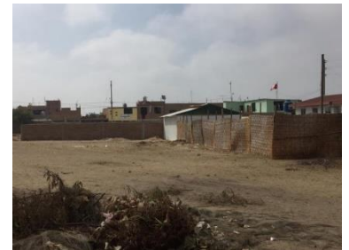
FOTOGRAFIA N°29: Vista del exterior Fuente: trabajo de campo
