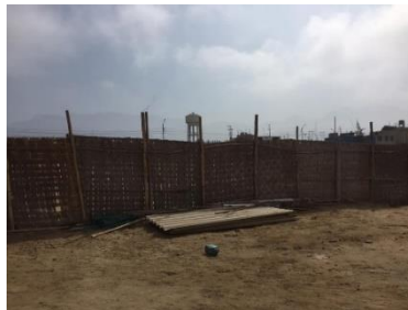
FOTOGRAFIA N°28: Cerco perimétrico de esteras Fuente: trabajo de campo
