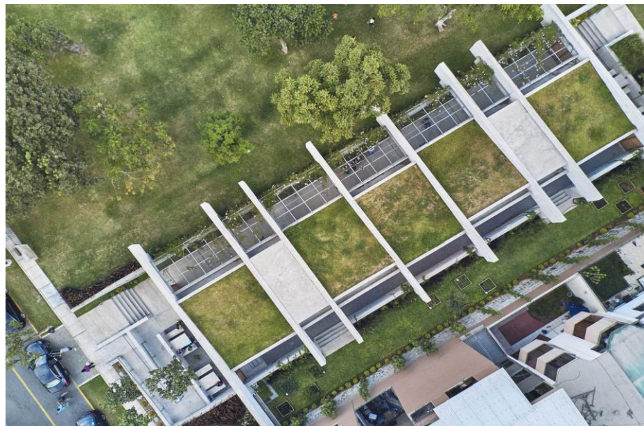
FOTOGRAFIA N° 59: Plaza Cultural Norte Fuente: Plataforma Arquitectura Por: Ramiro Del Carpio
