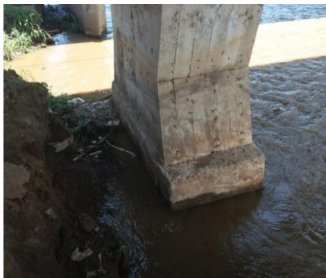
FIGURA 14 - Fotografía del pilar del puente – Puente Moche
