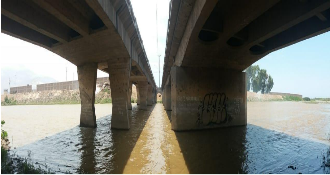
FIGURA 5 - Identificación de dos tipos de pilares.
