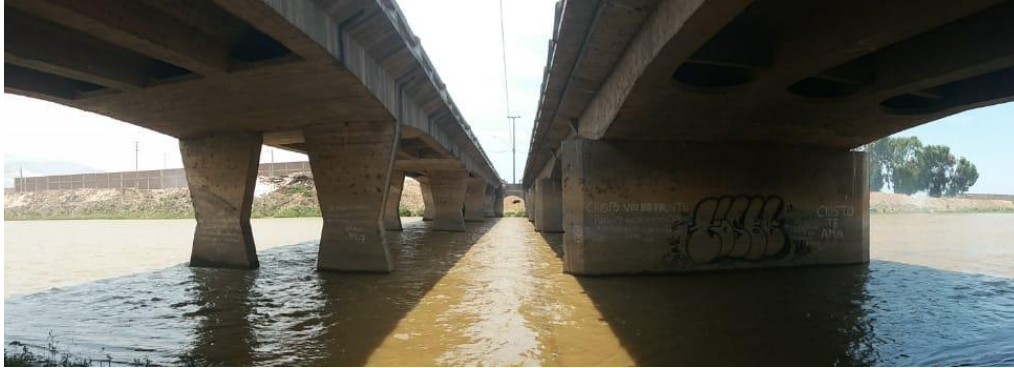
FIGURA 13 - Fotografía de Sub estructura – Puente Moche
