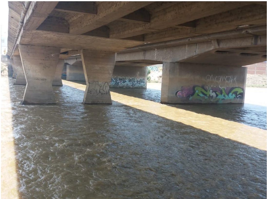
FIGURA 16 - Fotografía en perspectiva– Pilares del Puente Moche Fuente: Autoría Propia
