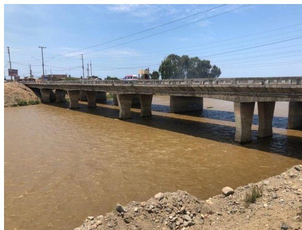
FIGURA 12 - Fotografía en perspectiva – Puente Moche
