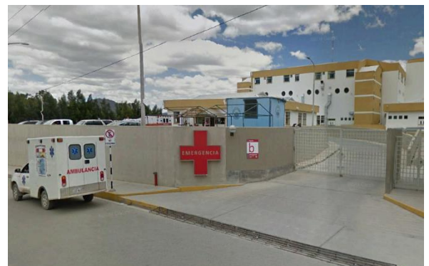
Ilustración 124: Ingreso de Emergencia
