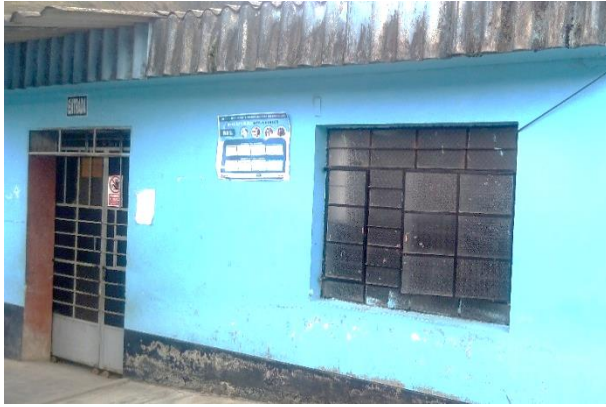
Ilustración 32: Vista exterior de Emergencia
