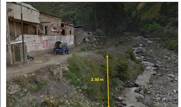
Ilustración 46: Pendiente más Baja – Riesgo Alto
