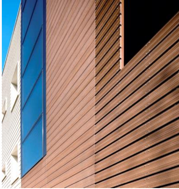
Ilustración 98: Ejemplo 1 - Revestimiento con WPC
