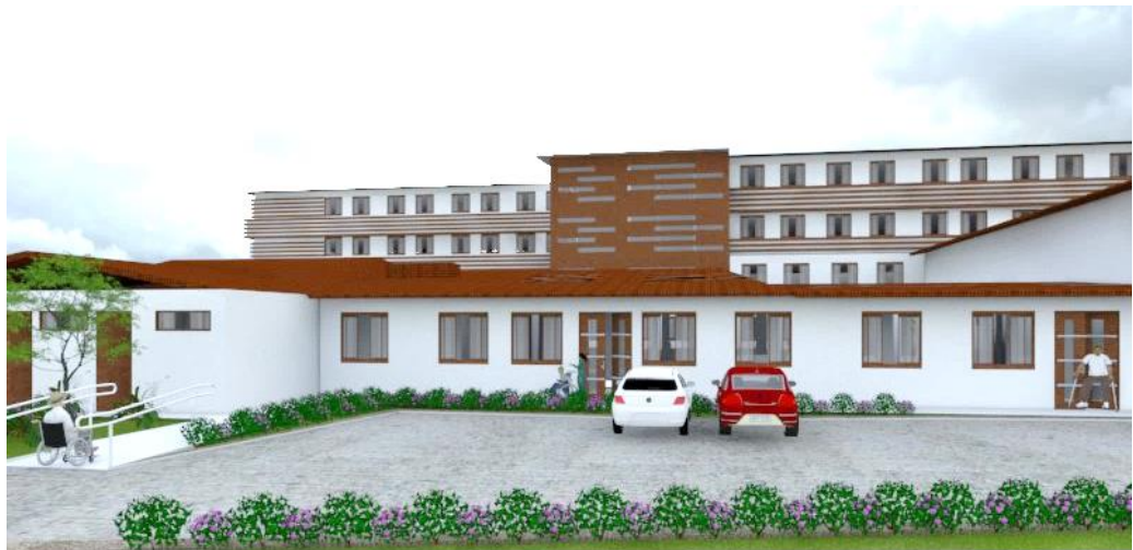
Ilustración 91: Ingreso a Unidad de Rehabilitación
