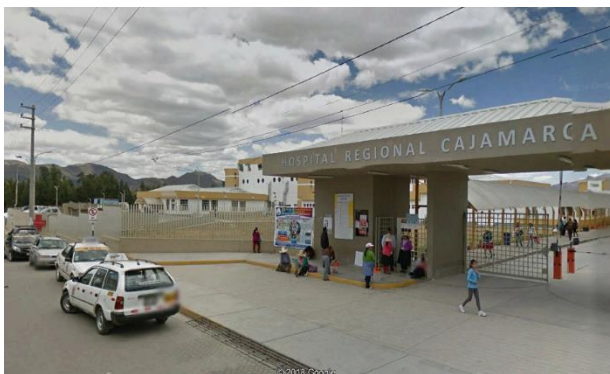
Ilustración 123: Ingreso Principal al Hospital Regional
