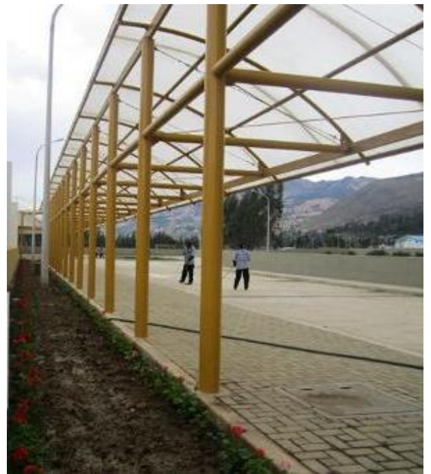
Ilustración 126: Hall de Ingreso
