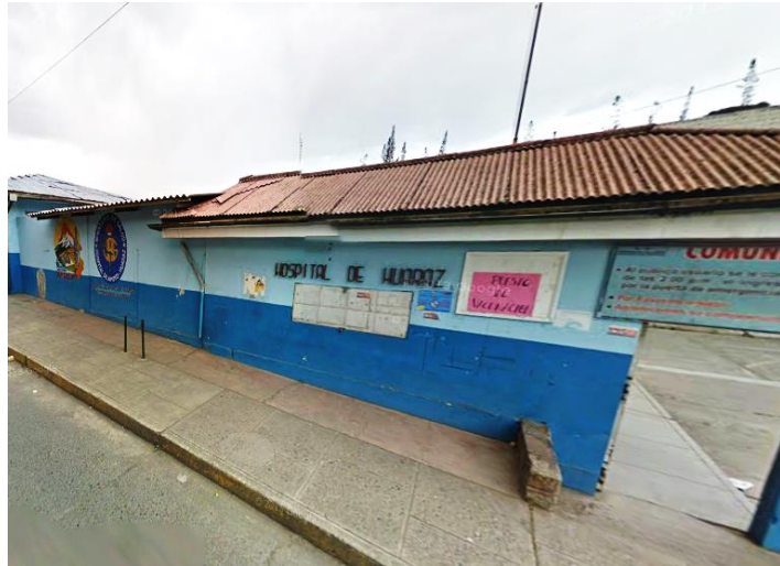
Ilustración 115: Uso del Eternit en Techos
