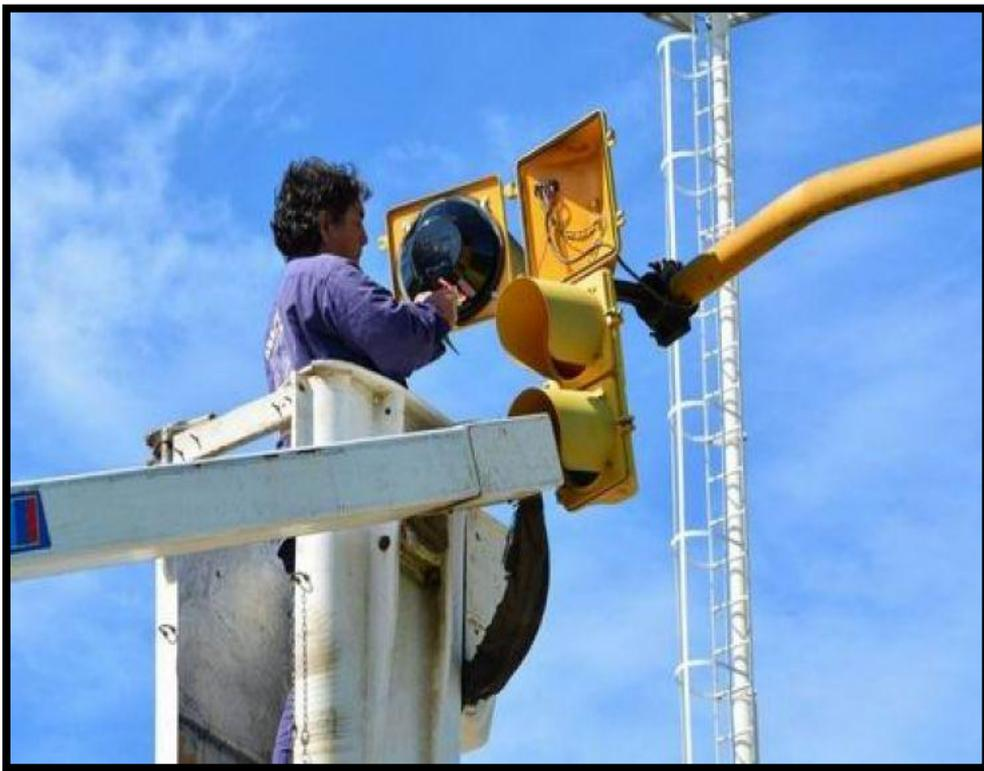
**FOTO 3.** Reparación y mantenimiento de semáforos
