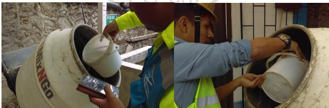
**Imagen 32:** Preparación de la tanda de mezcla cronometrado
