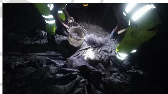
*Imagen 21: (4) Medición volumétrica, cantidad de material de rebote
