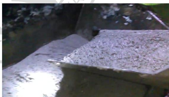
**Imagen 27:** Trasegado del Shotcrete de Mixer a Robot Lanzador, de flujo constante, sin atrapamiento de aire (6)
