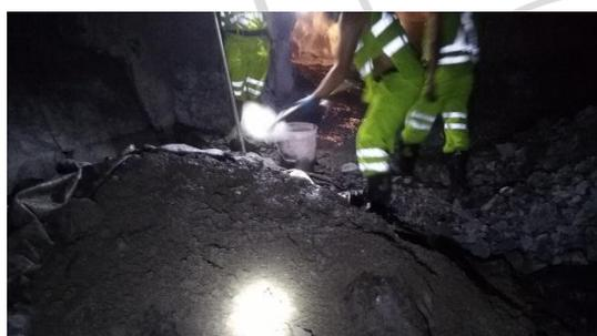
*Imagen 20: (3) Acopio material rebote post operación de lanzado del Shotcrete
