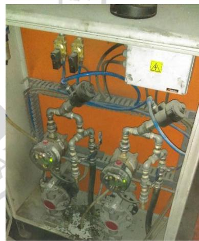
**Imagen 9:** Sistema de bombeo de aditivo en Planta Premezclado
