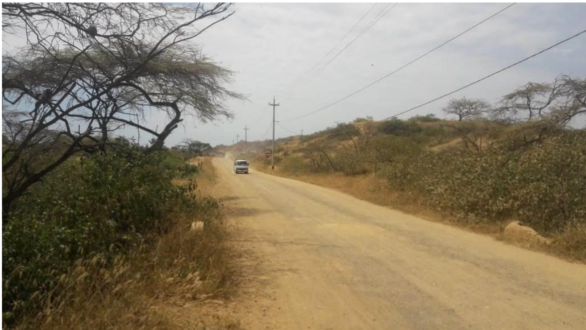
Fotografía 2: Ancho de calzada reducido
