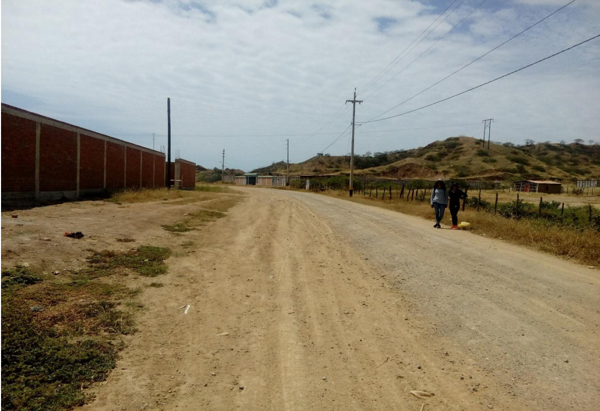
Fotografía 1: Estado actual de capa de rodadura
