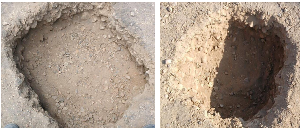
Foto 08 – Extracción de muestras mediante calicatas en cruces viales.
