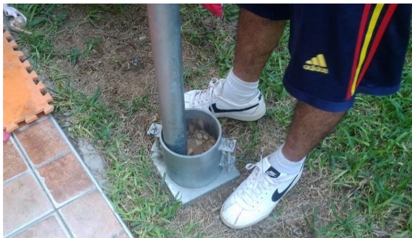
Foto 16 – Compactación de material dentro del molde
