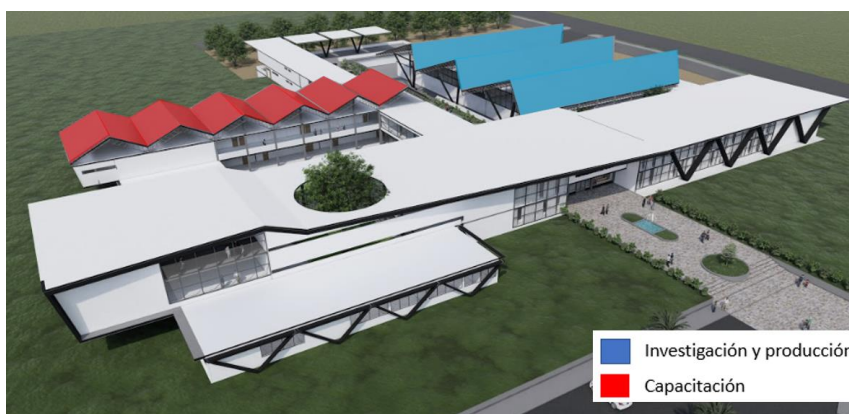
IMAGEN N°50: Área de utilización de paneles
