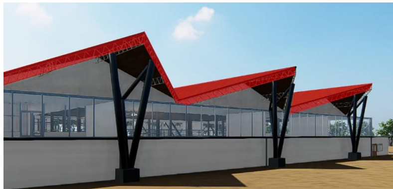
IMAGEN N°53: Inclinación de techos Zona de Investigación
