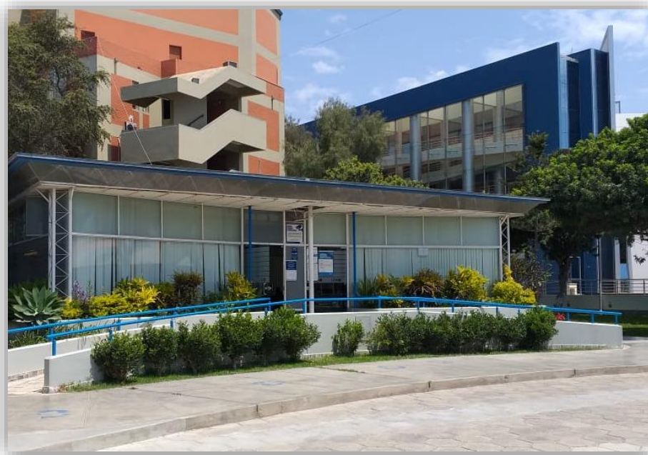
Figura 2 Fachada de la Plataforma de Atención al Usuario
