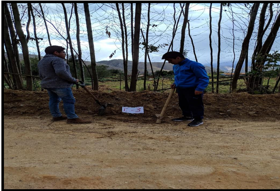
Fotografía 04: Ubicación de calicata N° 03 para su posterior excavación.
