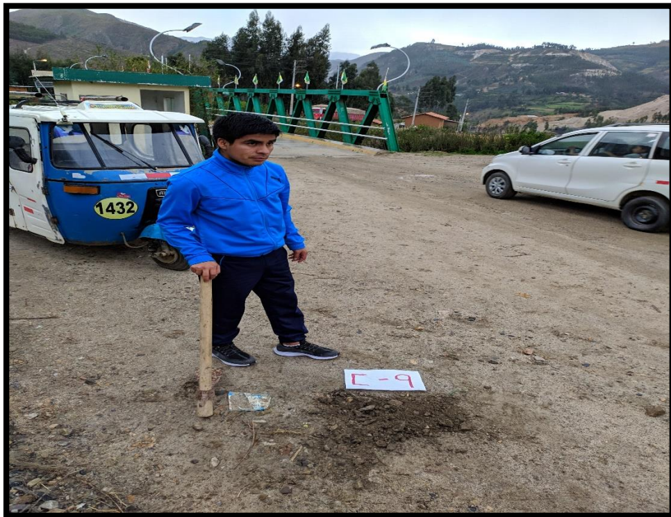
Fotografía 10: Ubicación de calicata N° 09 para su posterior excavación.
