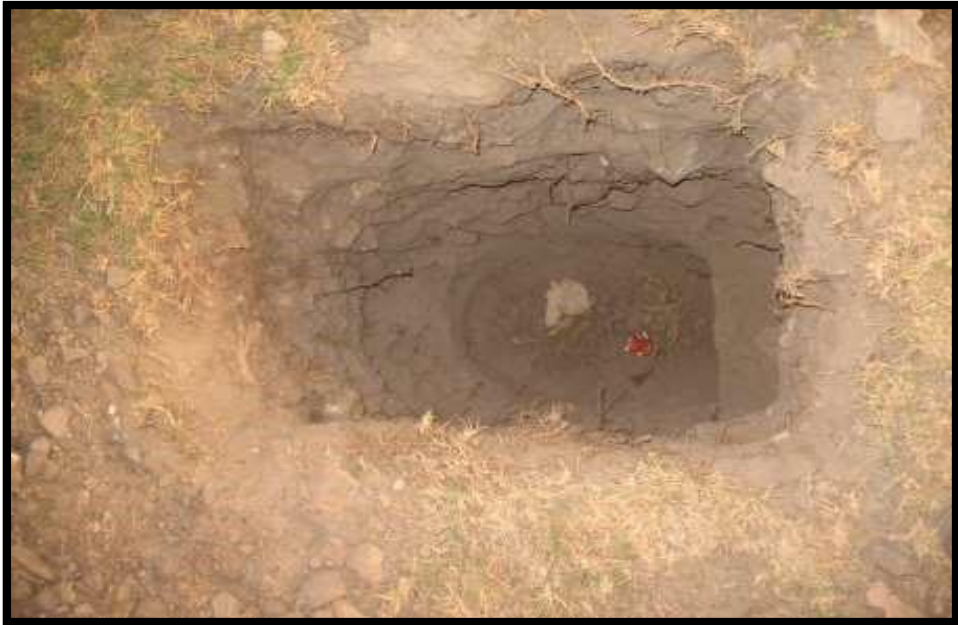
Fotografía 08: Ubicación de calicata N° 07 para su posterior excavación.
