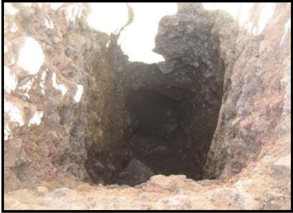
Fotografía 07: Excavación de la calita N° 06 y toma de muestra.
