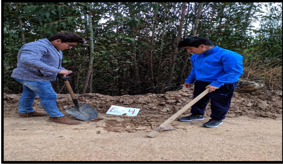
Fotografía 05: Ubicación de calicata N° 04 para su posterior excavación.
