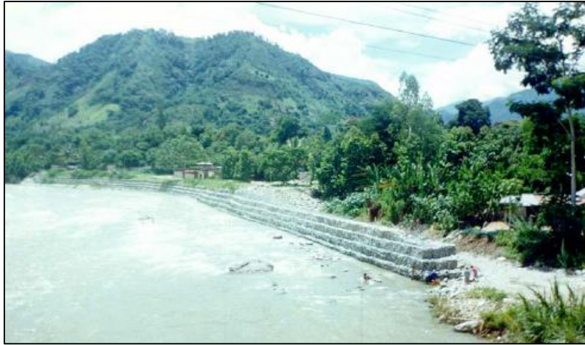
Fig. 50 Aplicaciones de gaviones – Río Tulumayo - San Ramón Junín-Perú Fuente: ANDEX
