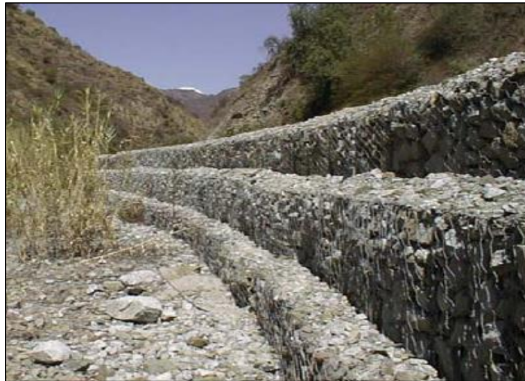
Fig. 57 Aplicaciones de gaviones – Defensa Ribereña Carretera Cusco Abancay (CUSCO) Fuente: Maccaferri
