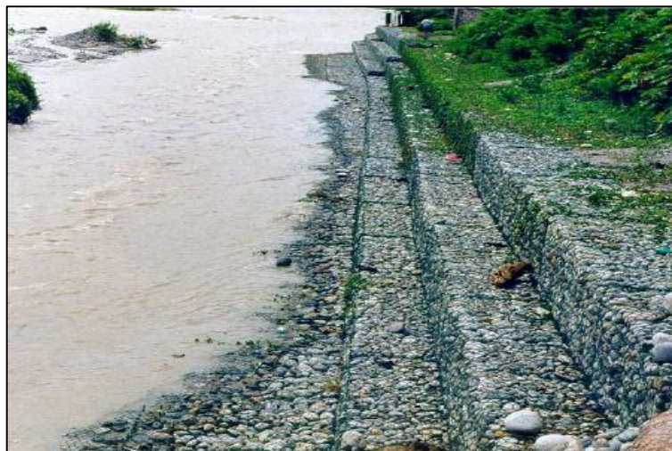
Fig. 52 Aplicaciones de gaviones – Río Chanchamayo Junín-Perú Fuente: ANDEX
