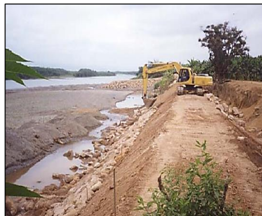
Fig. 32 enrocado de protección al pie del talud Fuente: internet
