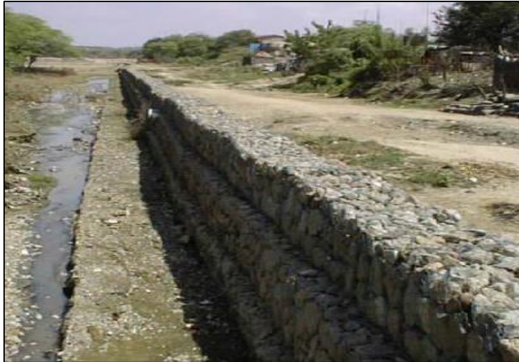
Fig. 53 Aplicaciones de gaviones – Defensa Ribereña Tambogrande (SULLANA) Fuente: Maccaferri
