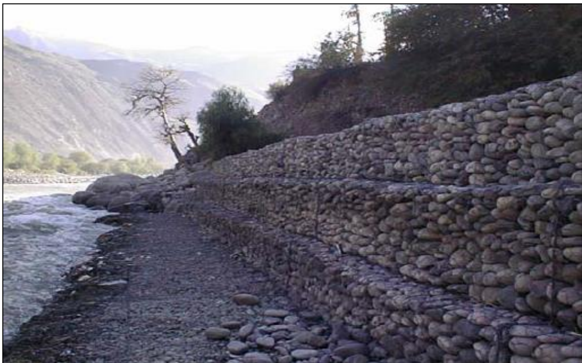
Fig. 59 Aplicaciones de gaviones – Defensa Ribereña Casinchihua (ABANCAY) Fuente: Maccaferri (Toro, DISEÑO DE MUROS DE GAVIONES, 2002)
