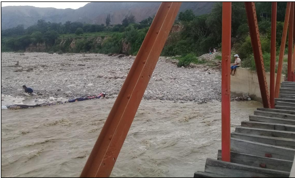
Foto 5. Zona antes del puente se observa áreas de cultivo en su mayoría de uva
