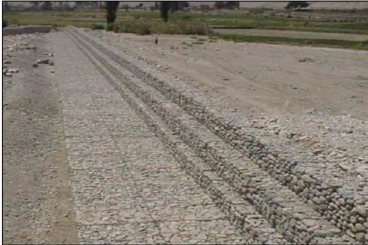
Fig. 56 Aplicaciones de gaviones – Muro de Encauzamiento Pte. Montalvo (MOQUEGUA) Fuente: Maccaferri
