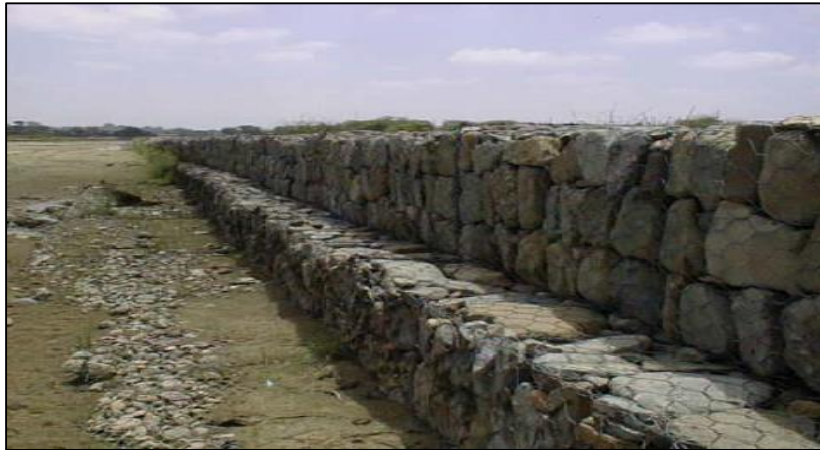
Fig. 51 Aplicaciones de gaviones – Muro de Encauzamiento Qda. Cieneguillo (SULLANA) Fuente: Maccaferri
