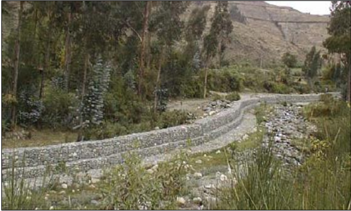
Fig. 58 Aplicaciones de gaviones – Defensa Ribereña Pisonay - Curahuasi (APURIMAC) Fuente: Maccaferri
