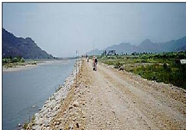
Fig. 34 Dique de tierra con enrocado Fuente: internet
