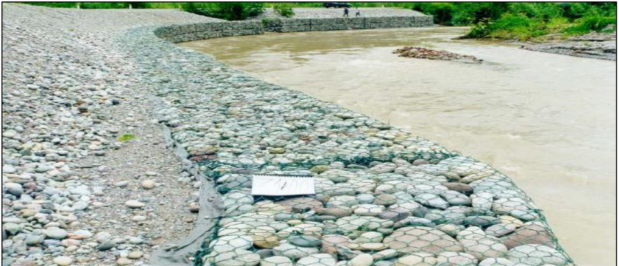
Fig. 48 Aplicaciones de gaviones – Carretera la Merced-Satipo Junín-Perú Fuente: Internet
