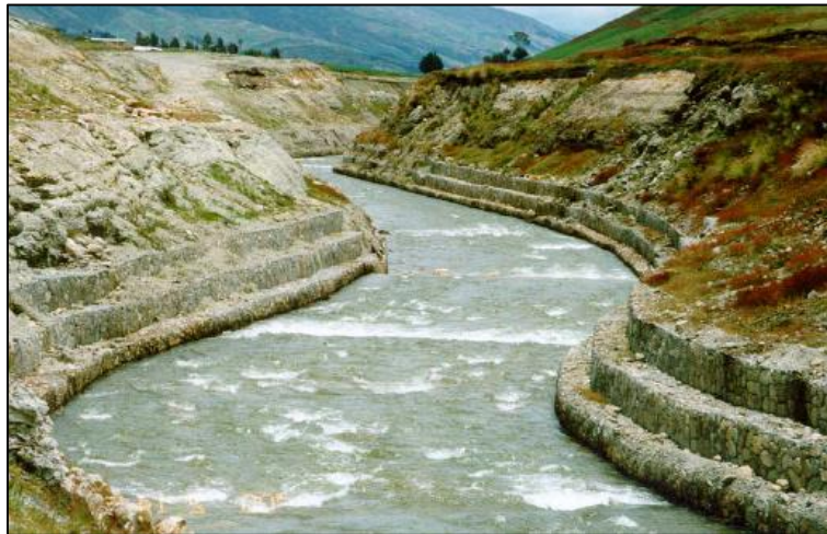
Fig. 54 Aplicaciones de gaviones – Cochabamba – Bolivia Fuente: ANDEX
