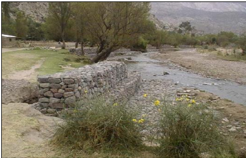
Fig. 49 Aplicaciones de gaviones – Defensa Ribereña Llamoctachi (AYACUCHO) Fuente: Maccaferri
