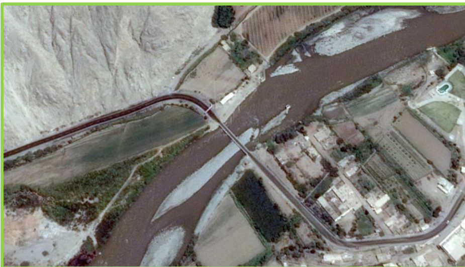
Fig. 50 Vistas aéreas del puente
