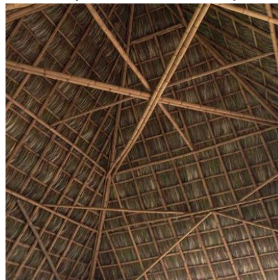
Imagen 31. Estructura interior del techo de una edificación y revestidas con hojas de palma
