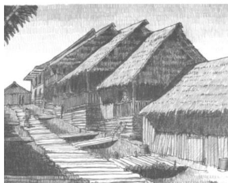
Imagen 28. Uso de la madera en los caminos y cimentación de las edificaciones
