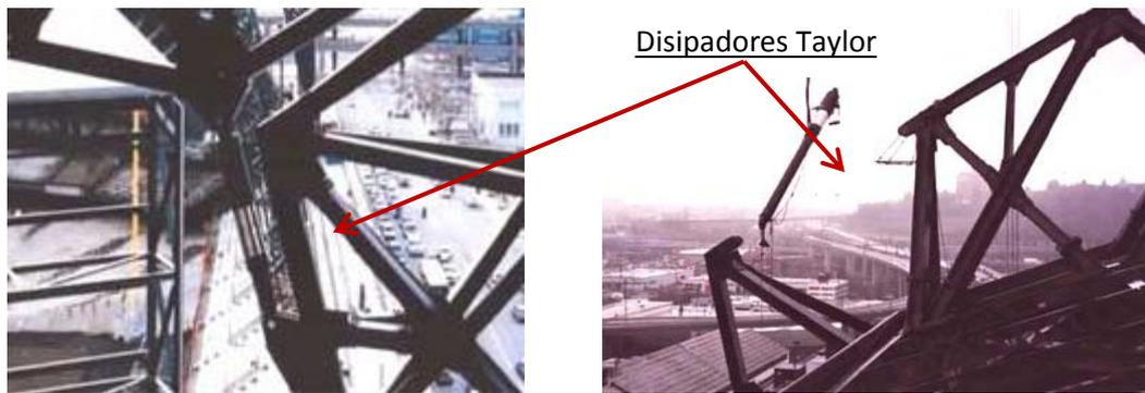
Fig.33 Instalación de los disipadores viscosos
