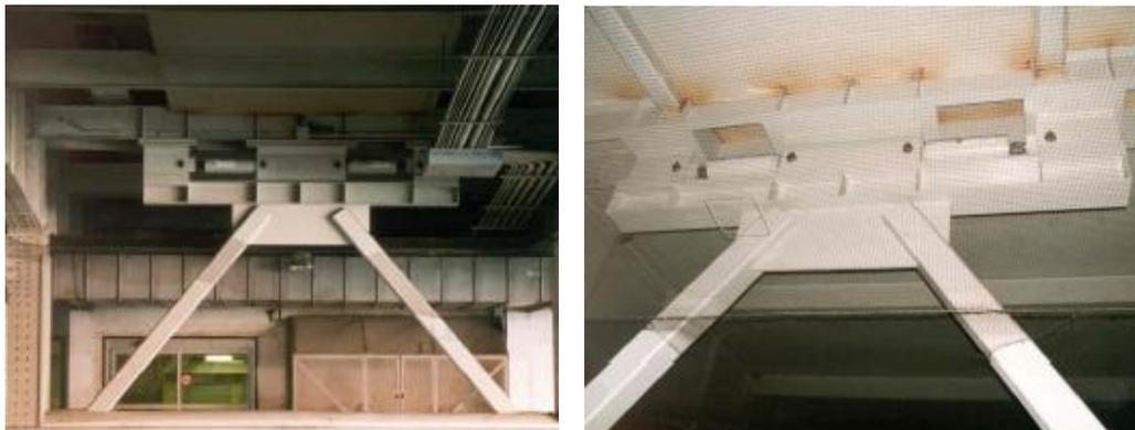
Fig.48 Refuerzo adicional que se emplea en la disposición Chevron
