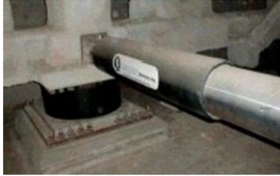
Fig.29 Instalación de los disipadores viscosos Taylor
