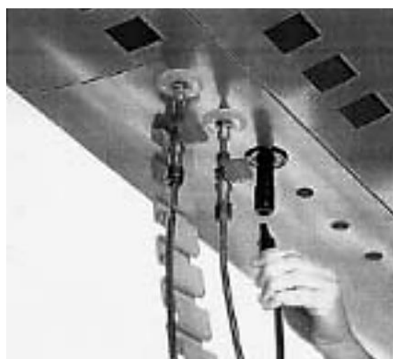
Figura 13: Sistema de conexión de equipos
