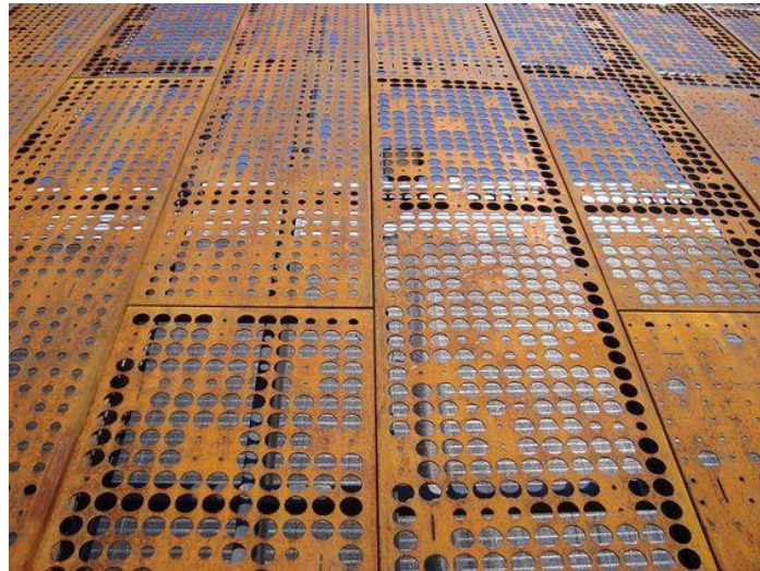
Figura 117: Fachada de acero corten perforado
