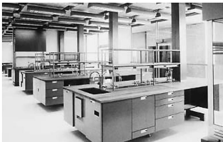
Figura 7: Fotografía del interior de los Laboratorios Salk, La Jolla, California
