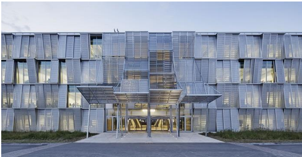
Fotografía Fachada Sur Pabellón de Ingeniería Mecánica, EPFL
