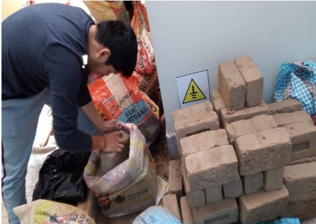
Foto N° 03: Traslado de material. Fuente: Autoría propia.
