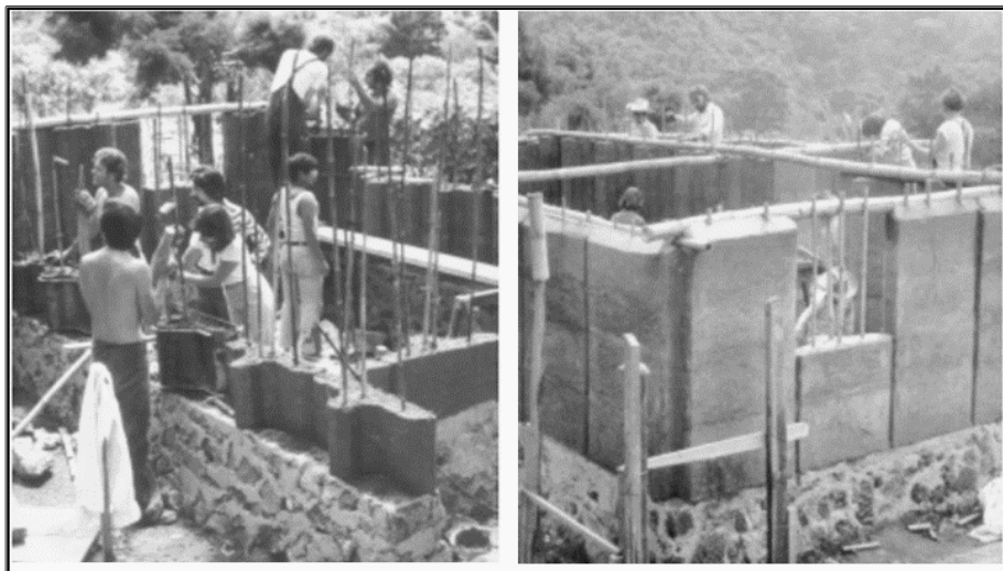
Figura 23.-Paneles de tapial reforzado con bambú
