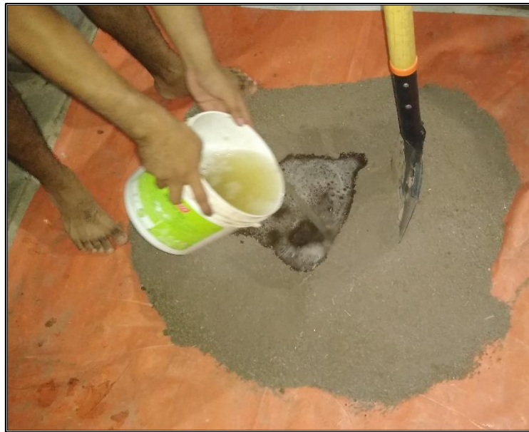
Preparación de mezcla para Tapial
