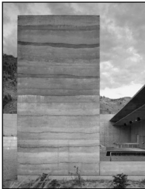
Figura 15.-Muro monolítico de tierra comprimida: Tapial
