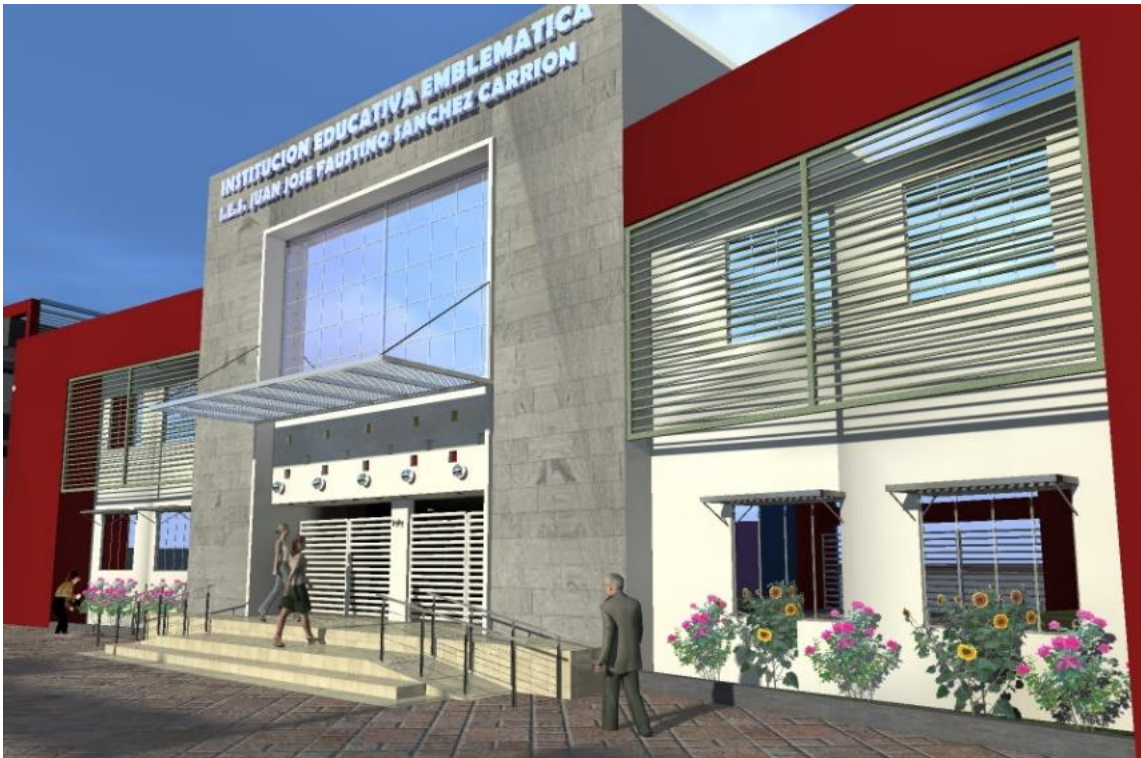
Imagen 10.- Vista del ingreso del colegio IE GUE
