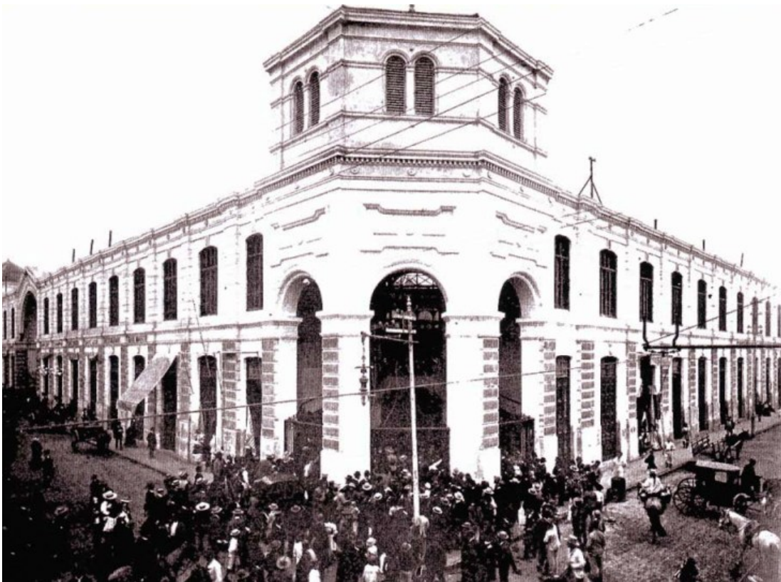
Imagen N°21: Mercado Central antes del incendio
