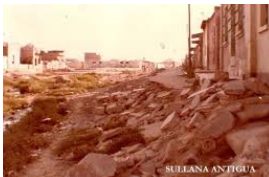
Imagen N°18: Calle Canchaque antes del fenómeno del niño de 1983
