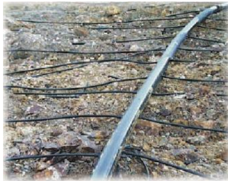
Figura N°2.4: Tendido del sistema de riego por goteo.
