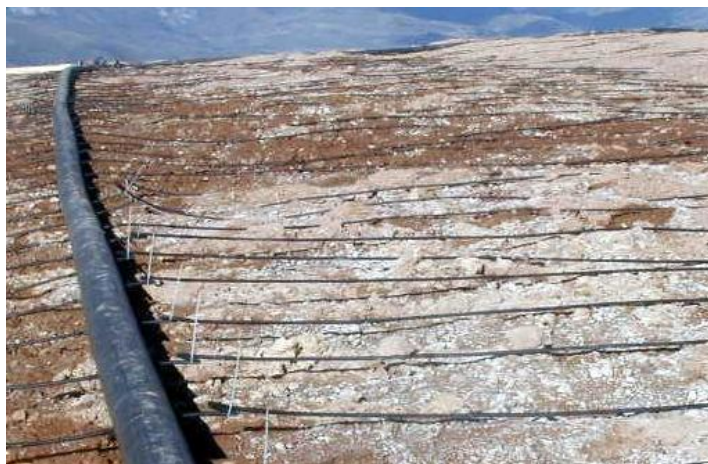
Figura N° 3.3: Líneas de goteros desde la tubería secundaria
