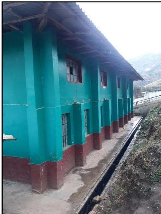
**Foto N° 06:** Deficiente construcción, columnas sin continuidad, vigas de madera y sin sistema de evacuación de aguas pluviales.
