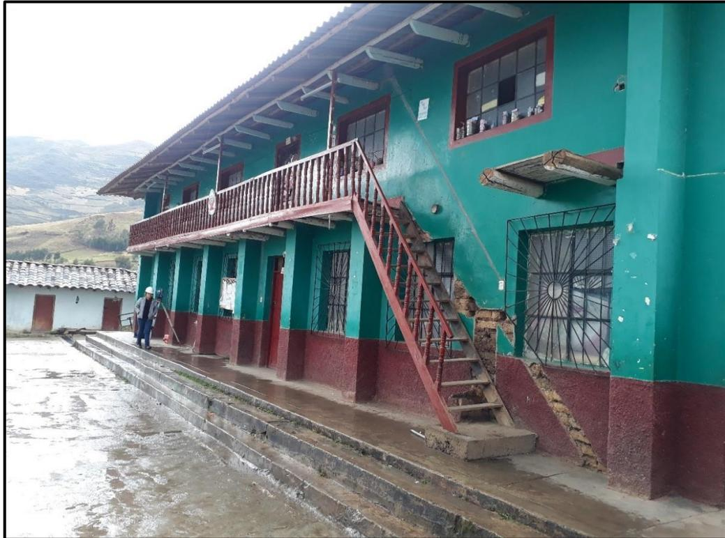
**Foto N° 05:** Módulo A de educación inicial, en mal estado, con escalera de madera y en condiciones críticas.
