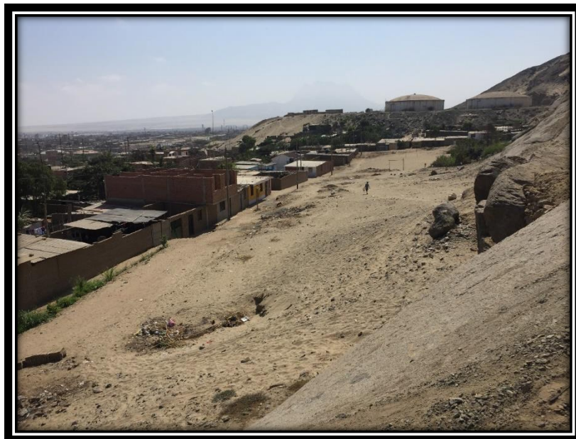
Imagen 20: Vista panorámica en donde se aprecia el área destinada para Recreación Pública (Manzana C) y viviendas de las Manzanas B y E, separadas por la calle 2.
