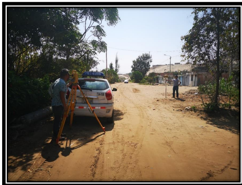
Imagen 12: Calle 5, levantamiento topográfico, con estación total.
