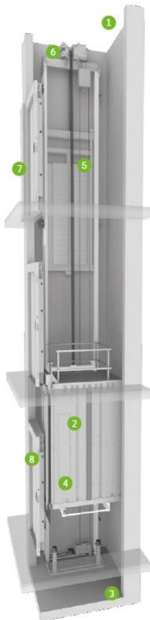
IMAGEN N°40: ESTRUCTURA EN CORTE DE ASCENSOR SCHINDLER
