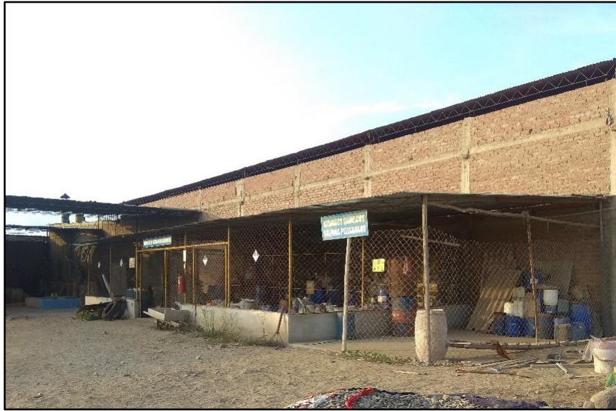
Figura 14: Almacén de residuos químicos
