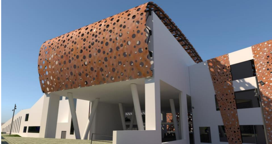
Figura N° 55: Frente posterior central de la edificación
