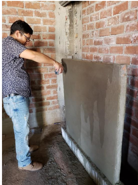
Foto N°40: Curado de los muros
