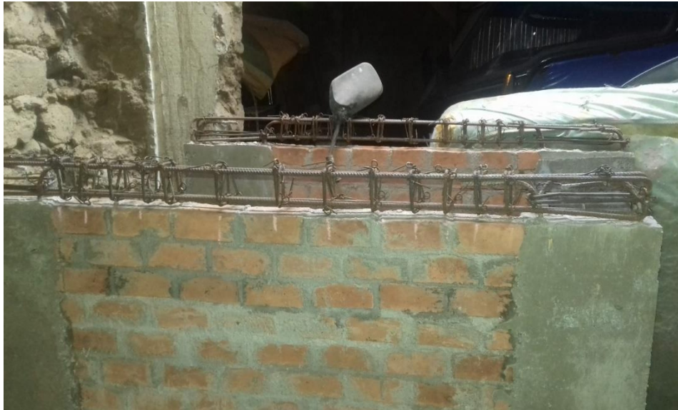
Foto N°05: Armado de la viga collarín o solera.
