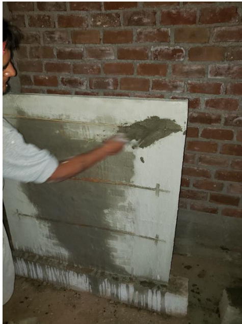
Foto N°28 y N°29: Colocación del refuerzo horizontal
