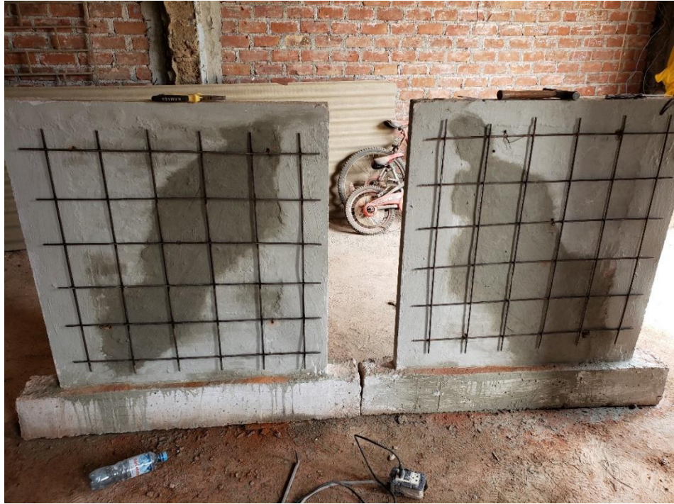
Foto N°37: Muros M2 y M2' luego de asegurar las mallas electro soldadas
