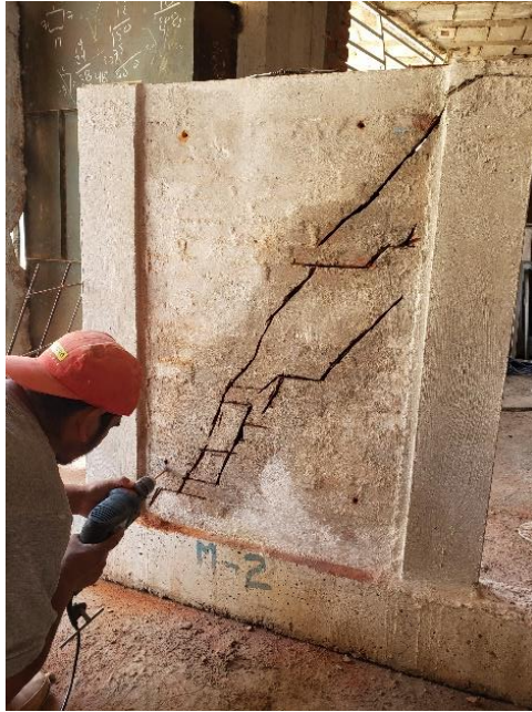
Foto N°34: Perforación del muro para asegurar la malla electrosoldada
