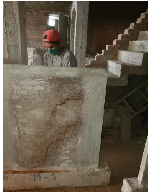
Foto N°22 y N°23: Picado de las fisuras más importantes
