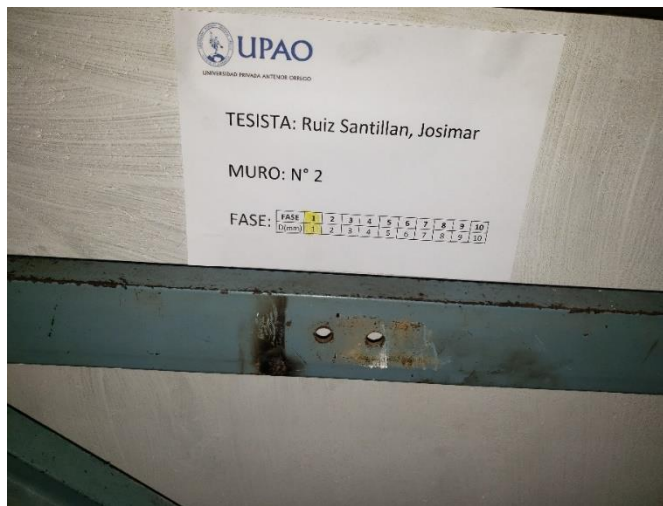
Foto N°73: Inicio de la primera fase del muro M2
