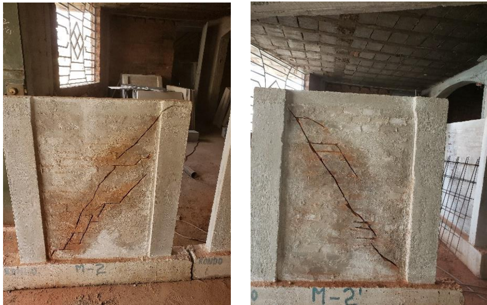
Foto N°32 y N°33: Picado de las grietas más importantes en los muros
