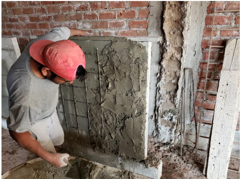
Foto N°38: Pañeteo de los muros
