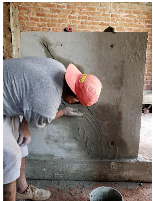
Foto N°24 y N°25: Humedeciendo el muro y aplicando mortero en las grietas
