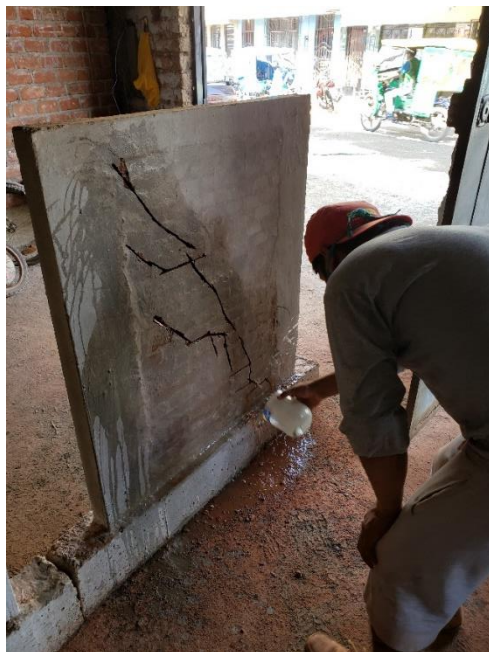
Foto N°24 y N°25: Humedeciendo el muro y aplicando mortero en las grietas
