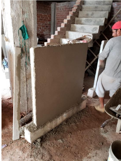
Foto N°39: Estado final de los muros
