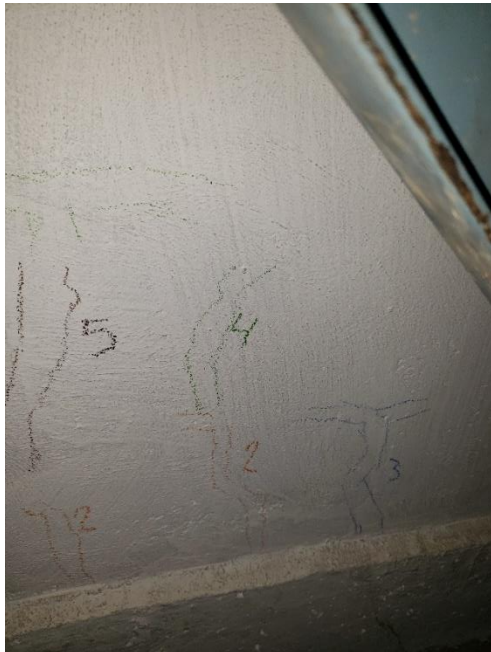
Foto N°75 y N°76: Fisuras verticales e inicio de fisuras en la viga de cimentación
