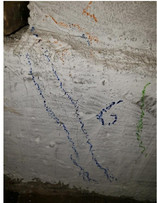
Foto N°75 y N°76: Fisuras verticales e inicio de fisuras en la viga de cimentación
