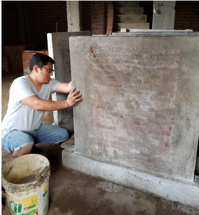
Foto N°21: Limpieza de los muros antes de iniciar las reparaciones Fuente: Autoría Propia
