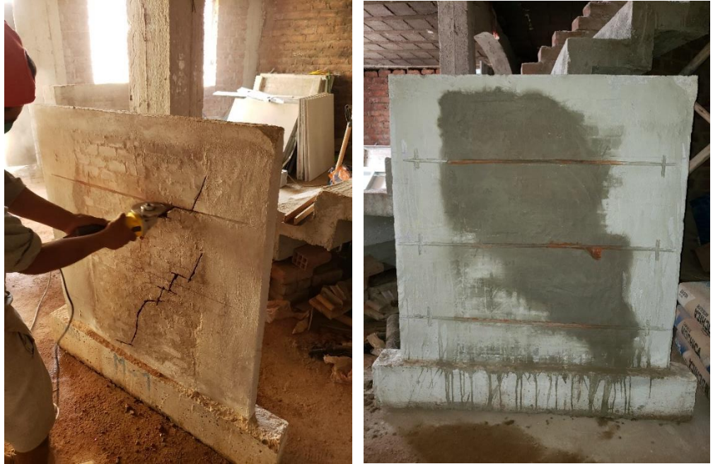
Foto N°26 y N°27: Canaletas para colocar el refuerzo horizontal
