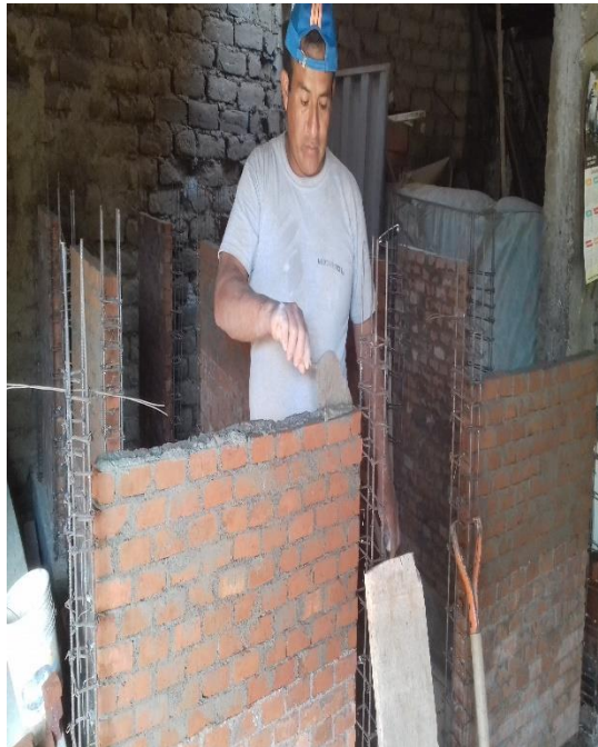
Foto N°03 Asentado de ladrillo
