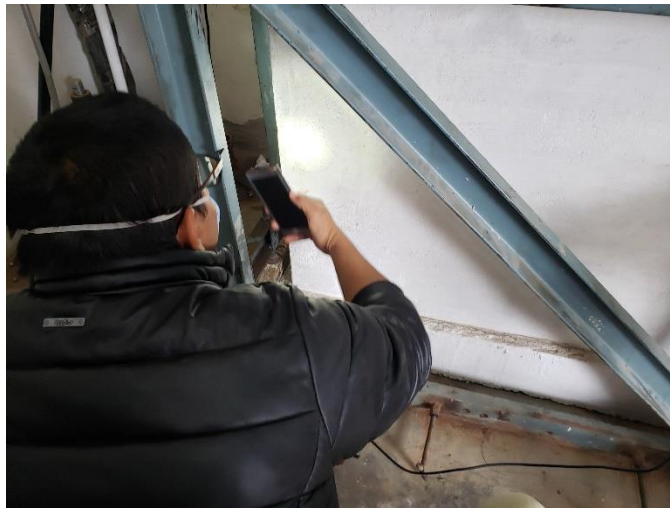
Foto N°50: Revisión de posibles fallas
