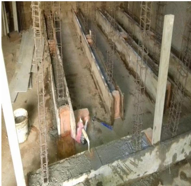
Foto N°02: Encofrado y vaciado de las vigas de cimentación
