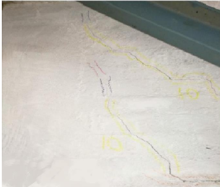
Foto N°11: Fisura en la fase 10 Fuente: Ref. N°07
