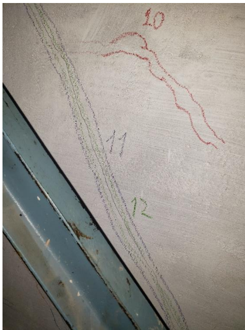
Foto N°61: Fisura diagonal falla por corte Fuente: Autoría Propia
