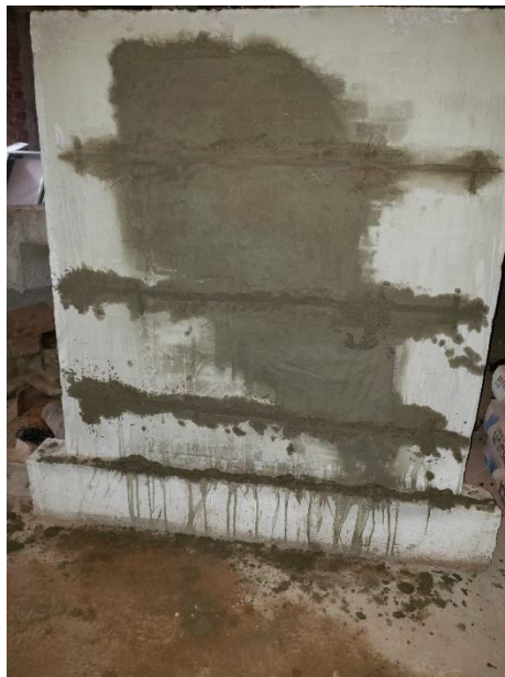
Foto N°30 y N°31: Estado final del muro reparado
