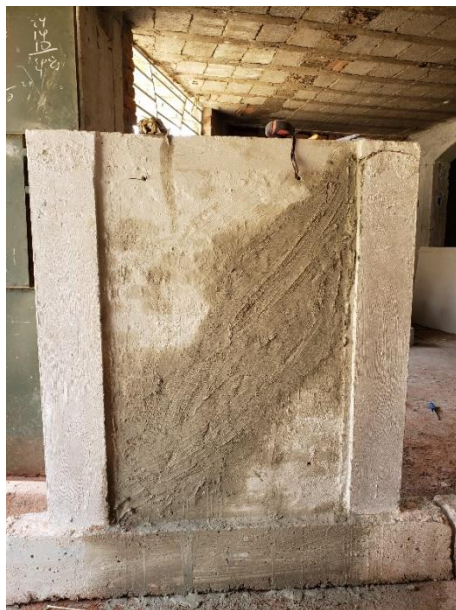
Foto N°35: Aplicación del mortero en el muro
