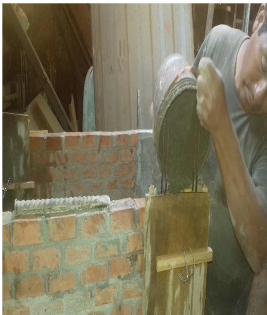
Foto N°04: Vaciado de columnas
