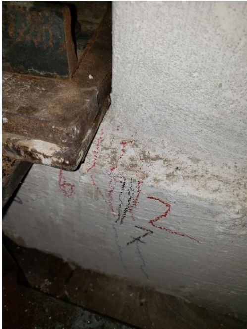
Foto N°69 y N°70: Fisuras en la viga de cimentación
