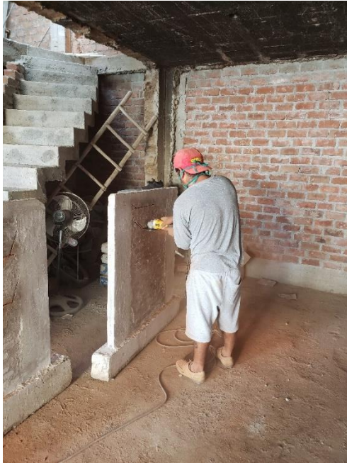
Foto N°22 y N°23: Picado de las fisuras más importantes
