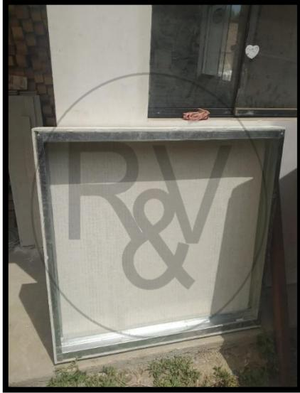
En nuestro primer prototipo se tomó el criterio de nuestro maestro de obra a cargo, usando placas de 8mm, parantes y rieles pesados. En la base se usaron 5 clavos de 1". Se realizaron 4 prototipos para este tipo de alféizar.
