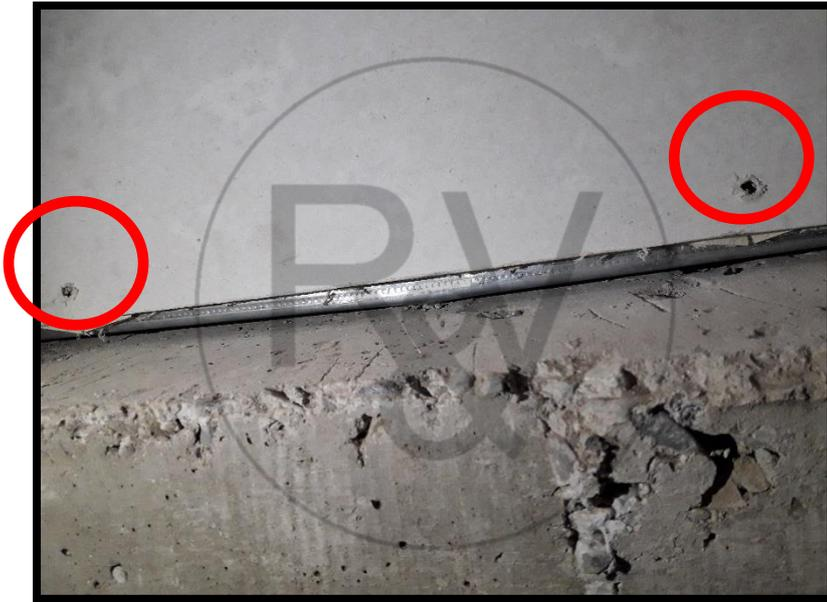
En la siguiente imagen se puede observar el desprendimiento de los tornillos autoavellanantes punta broca de la placa – riel y las deformaciones que presenta el riel durante su proceso de falla.
