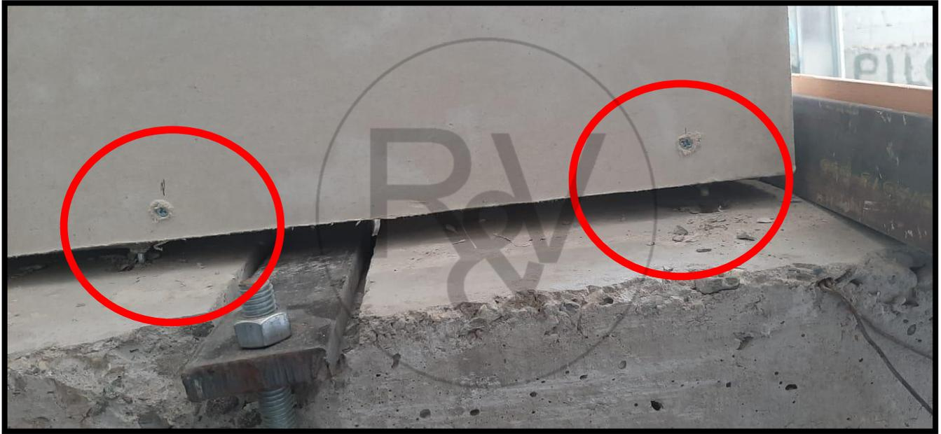
*Imagen Anexo 41. Vista de desprendimiento de anclaje en la base.
