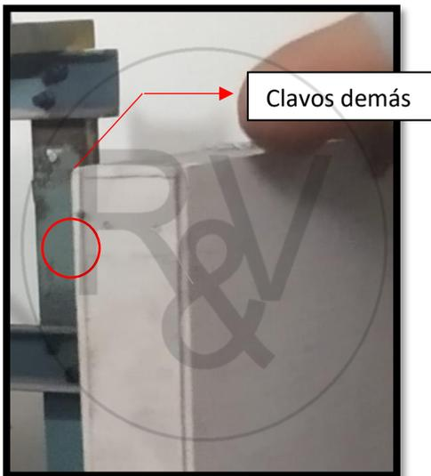
**Figura N°36: Exceso de clavos.**
