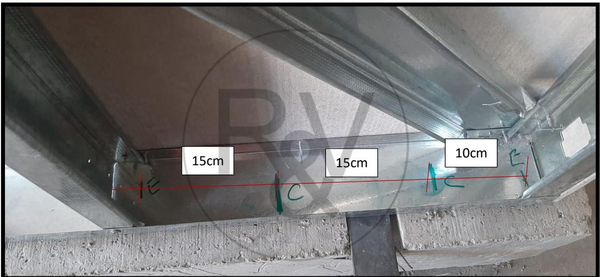
*Figura N°63: Prototipo 3 – separación de 15cm, lado B.
