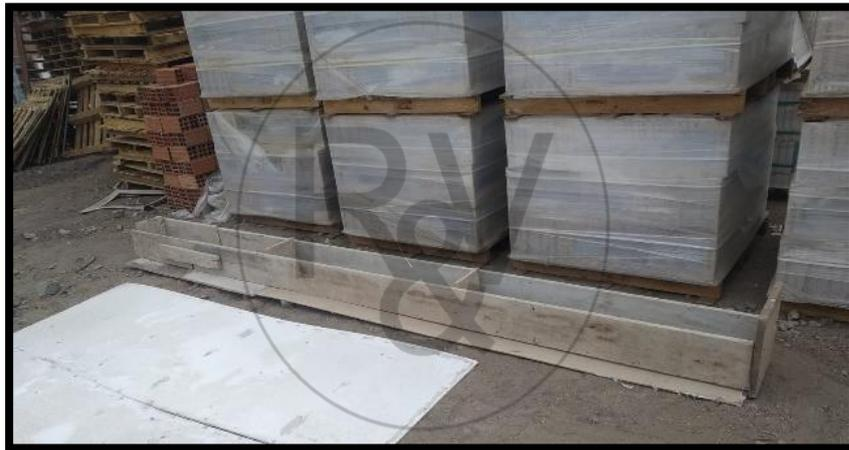
***Figura N°11: Encofrado de viga***
