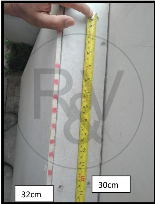
**Figura N°34: Separación de 30cm de clavos.**
