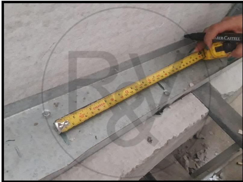
*Figura N°41: Prototipo 1 – separación de 17.5cm.
