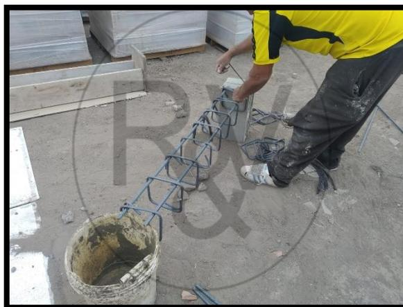
***Figura N°12: Armado de Acero***
