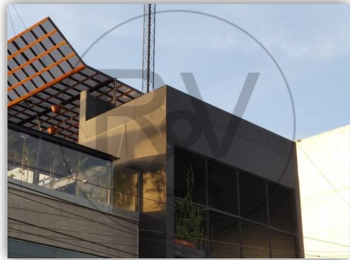
*Imagen Anexo 3. En el último piso podemos observar el uso de alfeizar Drywall como muro perimetral. Esta edificación está ubicada en la Av. Los Ángeles.*
