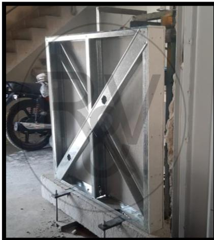
En nuestro tercer prototipo se construyó un nuevo prototipo realizado por nosotros, usando placas de 8mm, parantes y rieles pesados (En el muro se usó parantes en forma de X para rigidizar nuestro prototipo). En la base se usaron 4 clavos de 1" y 3 tornillos expansores. Se realizaron 4 prototipos para este tipo de alféizar.
