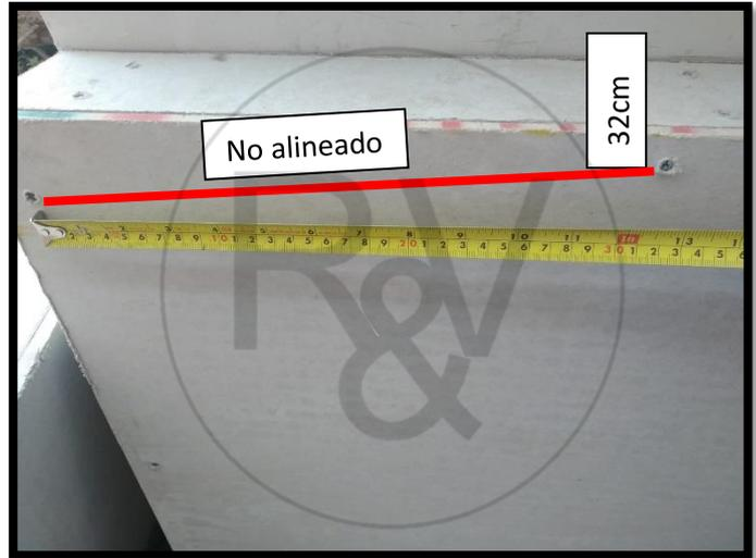
**Figura N°35: Clavos no alineados a cara de muro.**
