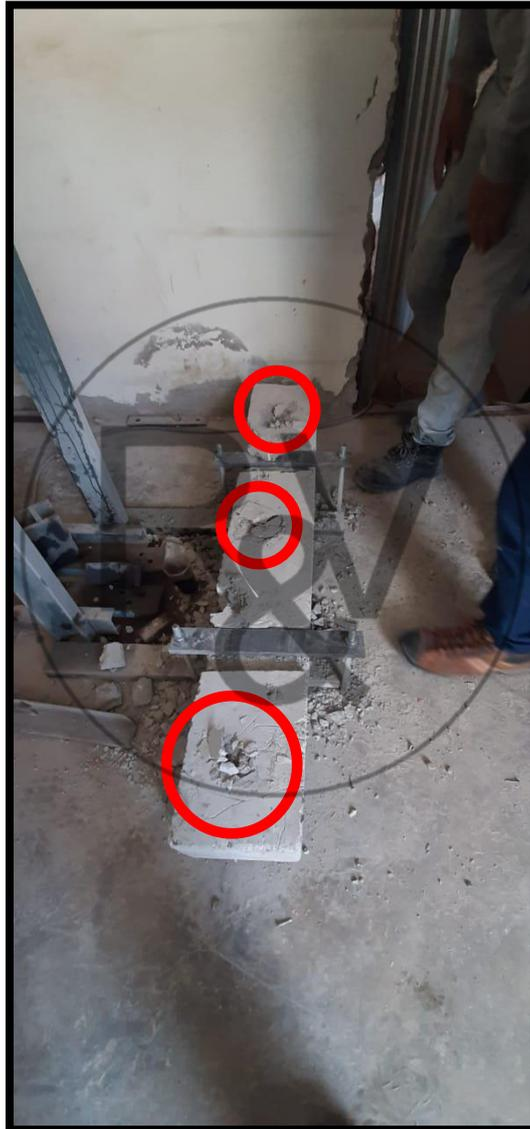
*Imagen Anexo 51. Impacto del perno de anclaje en la base.
