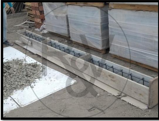
**Figura N°13: Encofrado con armadura de acero.**
