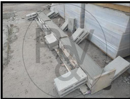
**Figura N°17: Vigas  $f'c$  210 Kg/cm<sup>2</sup> encofradas.**
