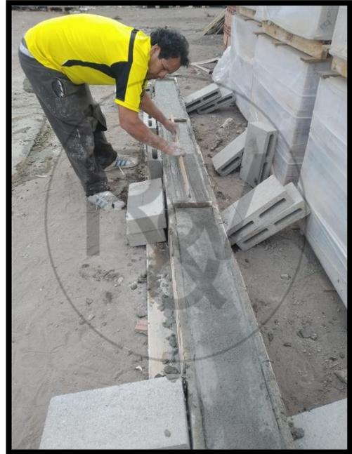
**Figura N°16: Reglado de Concreto.**
