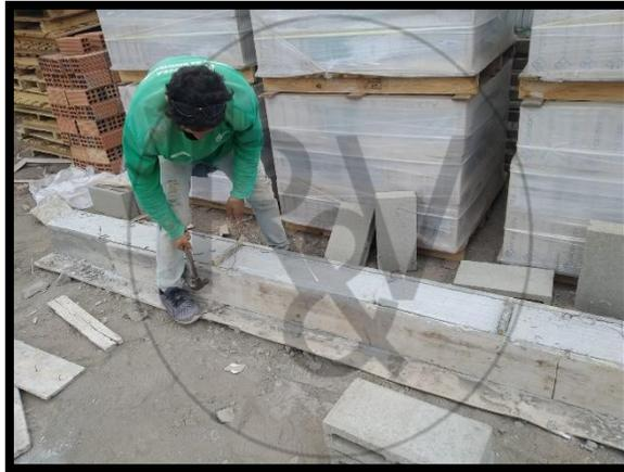
*Figura N°18: Desencofrado de Vigas*
