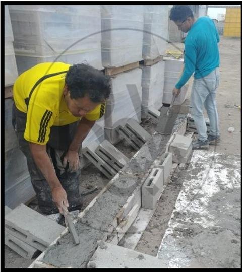
**Figura N°15: Apisonamiento de Concreto.**
