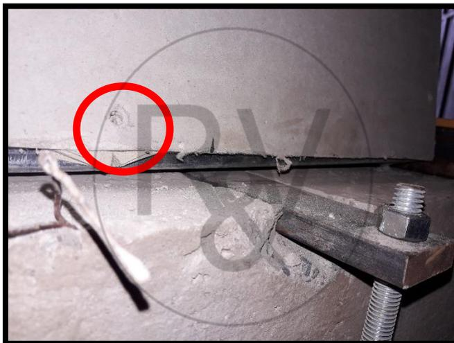
Se observa la salida o desprendimiento total del tornillo autoavellanante punta broca.
