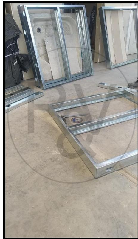
**Figura N°46: Separación de 50cm de parante.**
