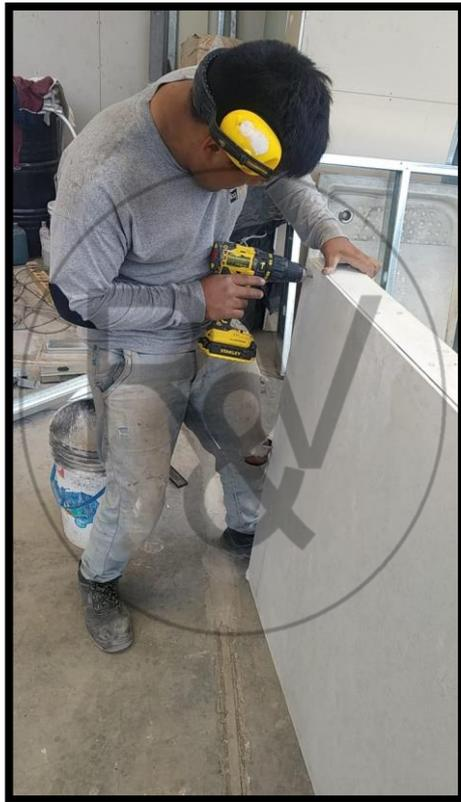
Ensamble de placas de 12mm – Prototipo 2.
