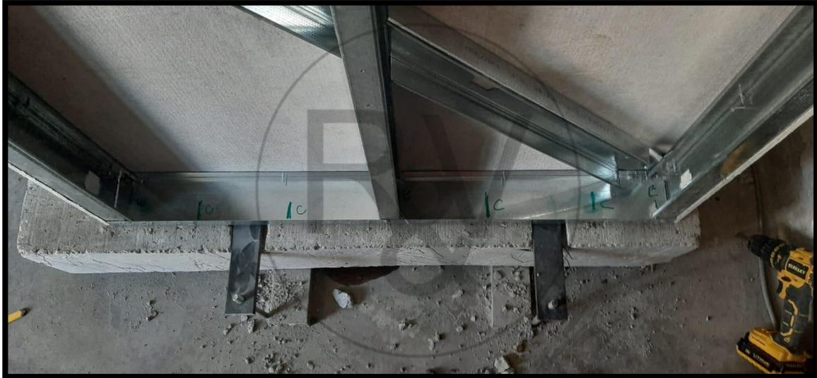
**Figura N°64: Prototipo 3 – Base de Muro de Drywall.**
