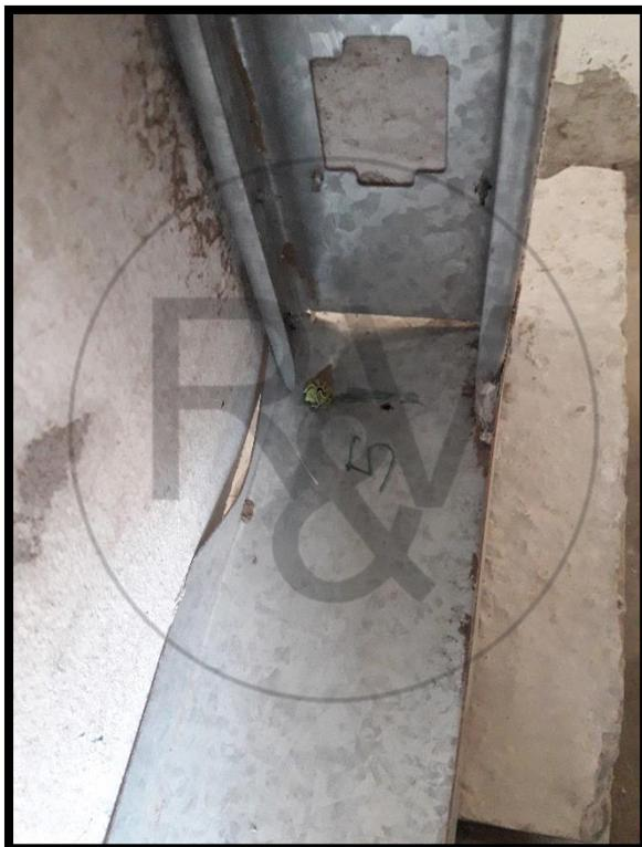
*Imagen Anexo 32. Deformación zona esquinada interna de riel.
