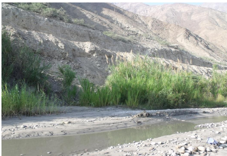
Foto 04: En Esta Foto se Puede Observar la Erosión del Suelo que Afecta la Red en el Margen Izquierdo del Rio Chicama
