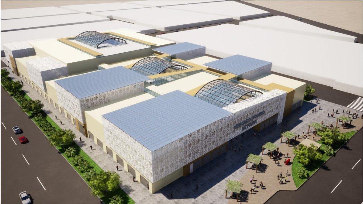
FIGURA N° 124: SISTEMA DE PANELES SOLARES
