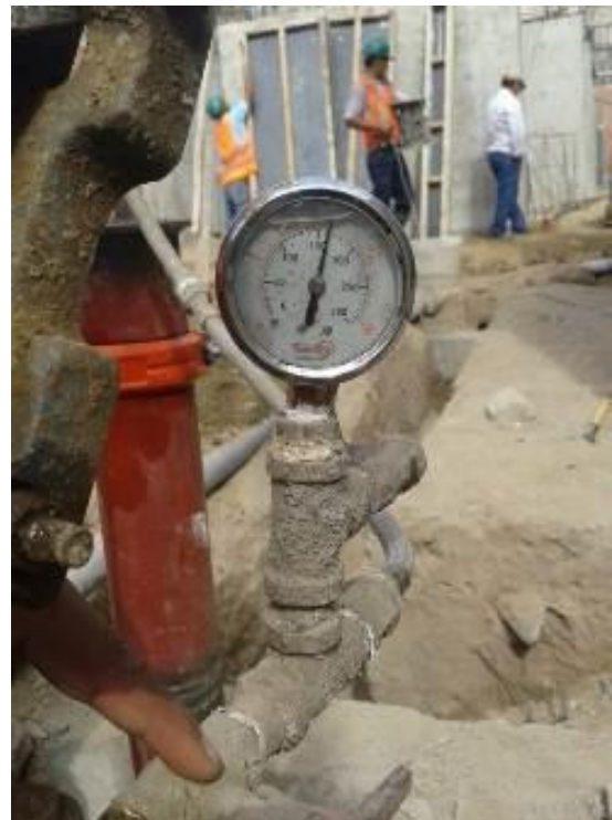
Se observa la instalación del tramo empotrado de tubería del Sistema Contra Incendio y el Ensayo de Presión Hidráulica.
