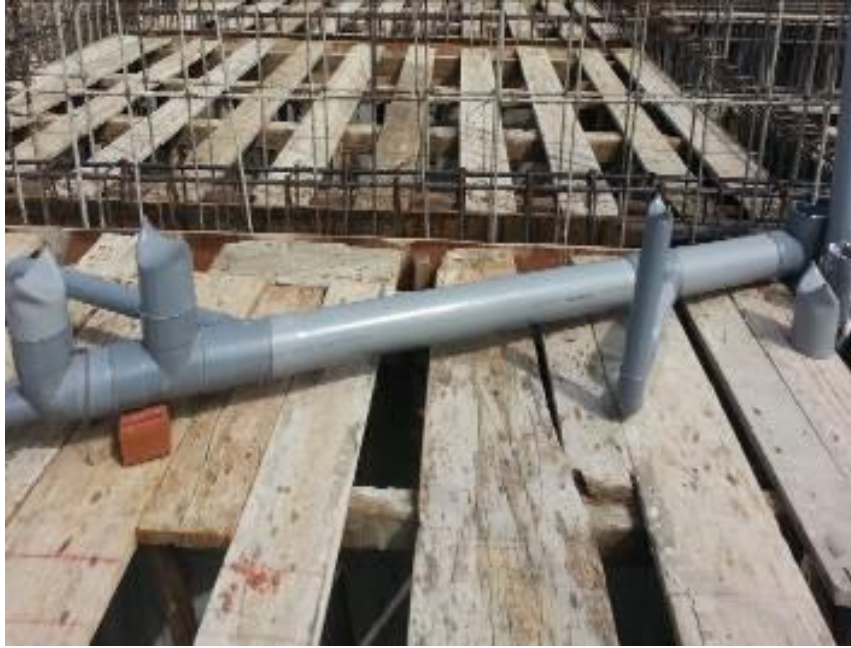
Se observa encofrado de techo de primer nivel.
