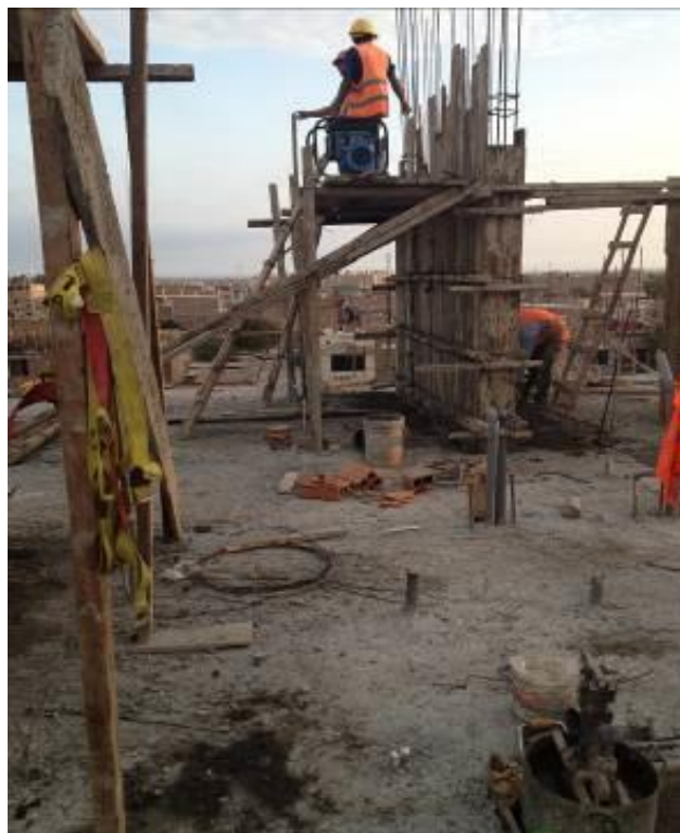
Se observa procesos de encofrado y colado de concreto de placas del 5to nivel del Bloque B.
