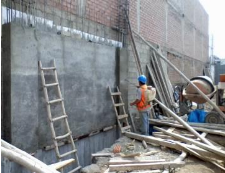
Se observa procedimiento de curado de placas con Sika Antisol.
