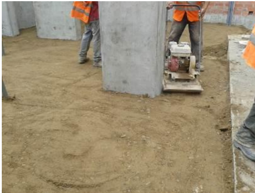
Se observa compactación de última capa de relleno, realizada con afirmado (15cm de espesor)
