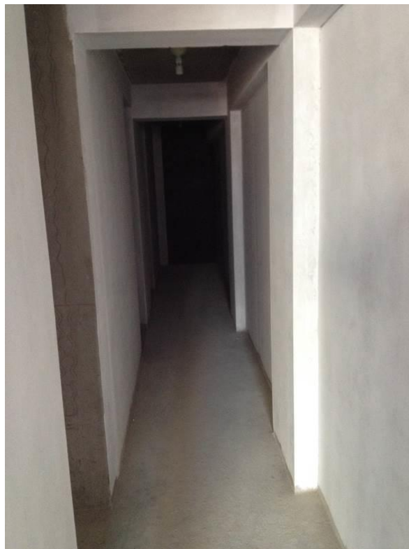
Se observa concluidos los trabajos de revestimiento de muros, vigas, columnas, cielorraso y contrapiso en el cuarto nivel.
