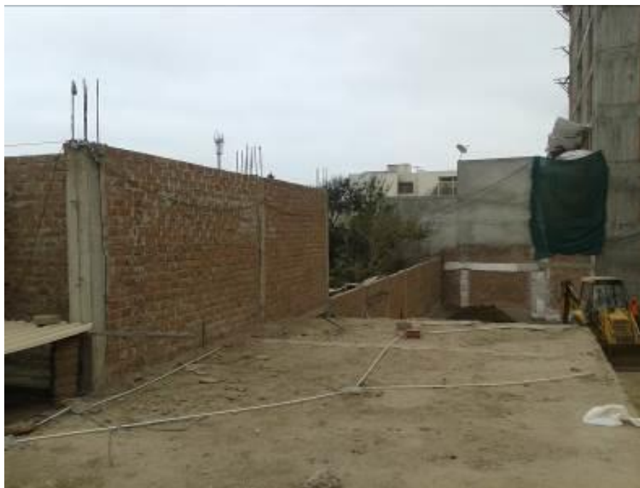
Retroexcavadora realizando los trabajos de limpieza y excavación de cisterna.
