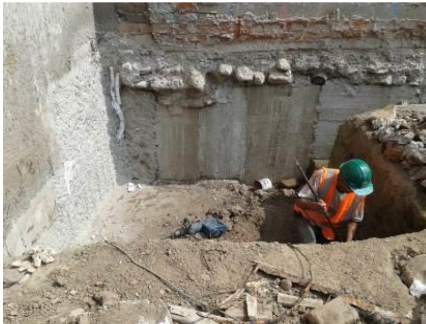
Se observa avance de excavación de zapatas Eje 5 - K
