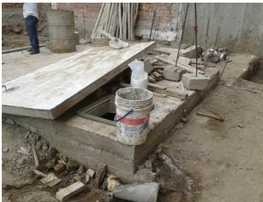
Se observa cisterna concluida.
