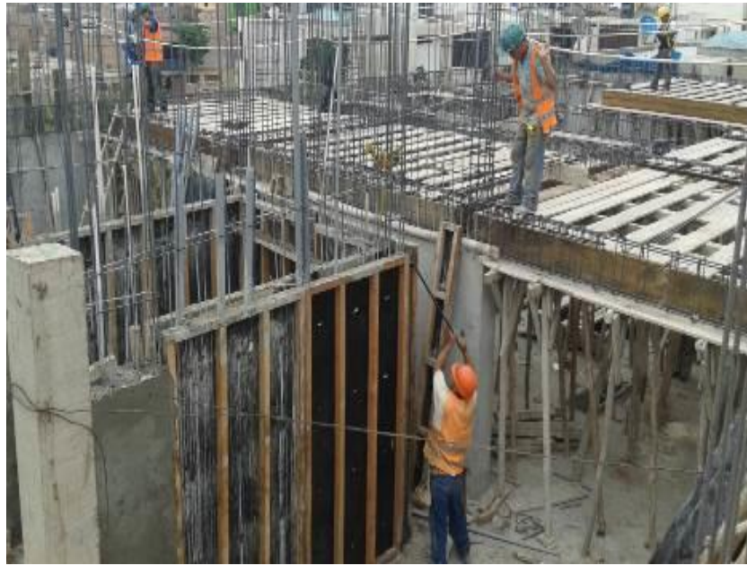
Se observa encofrado de techo del segundo nivel, del Bloque B.
