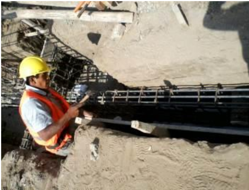
Se observa la habilitación de acero y encofrado de vigas de cimentación
