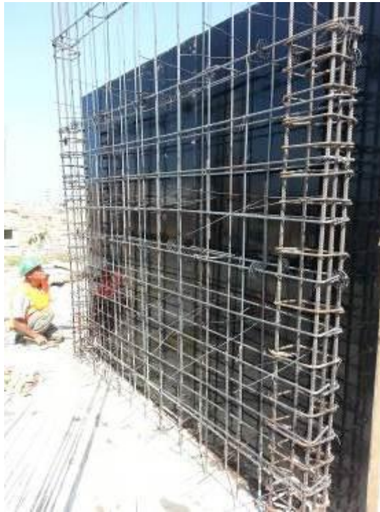
Se observa encofrado caravista de placas primer nivel.
