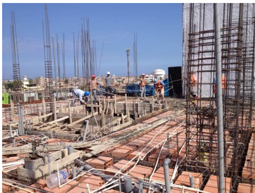
Se observa preparación de losa 5to nivel – Bloque B.
