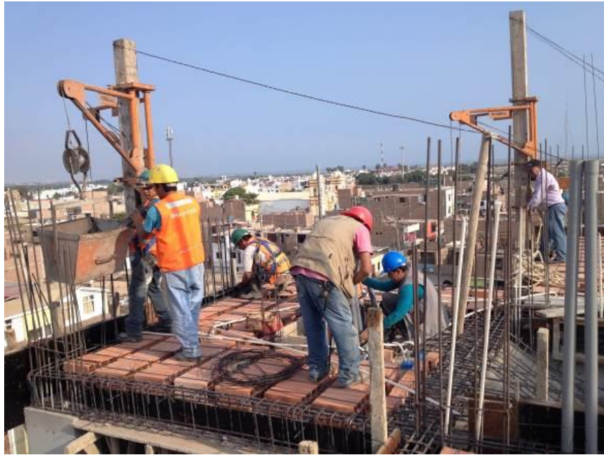
Se observa preparación de losa 7mo nivel y colado de concreto.
