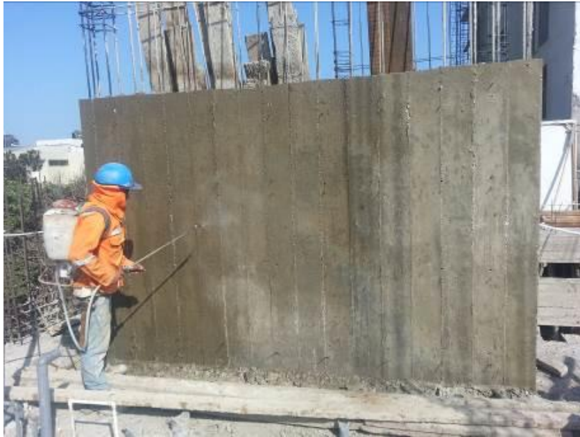
Se observan placas concluidas en segundo nivel y el proceso de curado.
