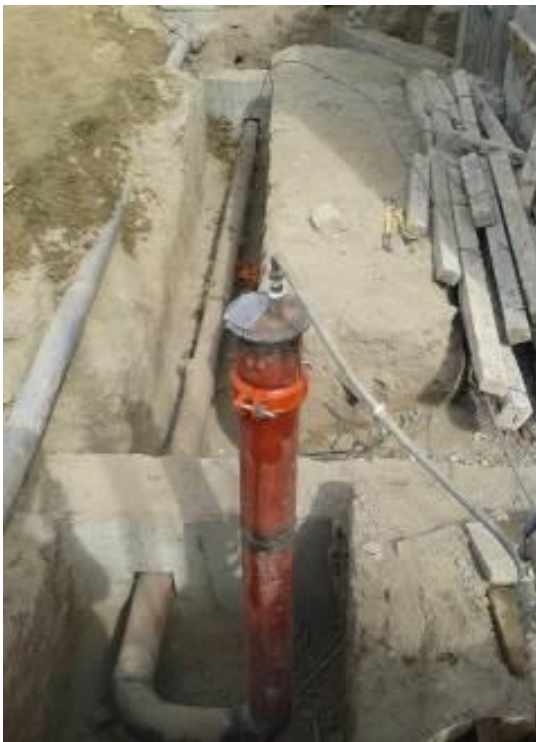
Se observa la instalación del tramo empotrado de tubería del Sistema Contra Incendio y el Ensayo de Presión Hidráulica.
