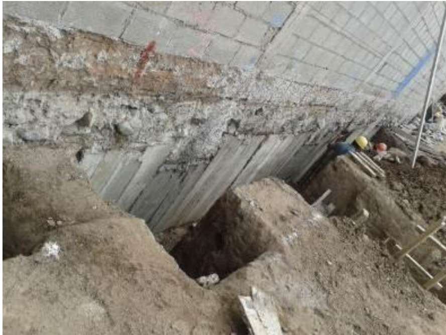
Se observa eje 1 – Bloque Posterior a un 50 % de desarrollo en calzada.
