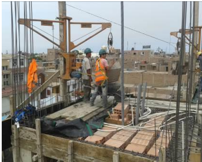
Se observa proceso de colado de concreto del techo del 3er nivel del Bloque B.
