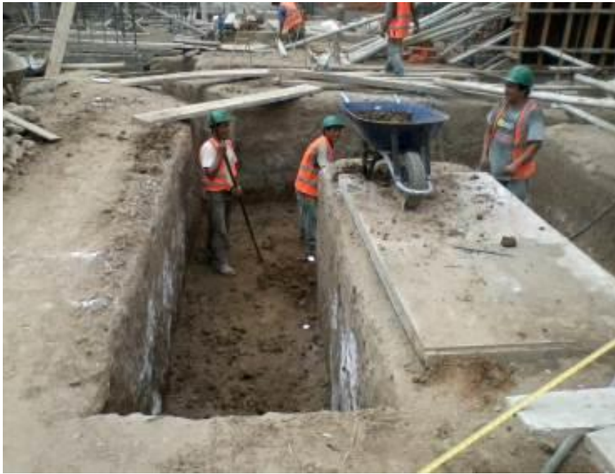
Se observa excavación de zapata – zona de escalera.
