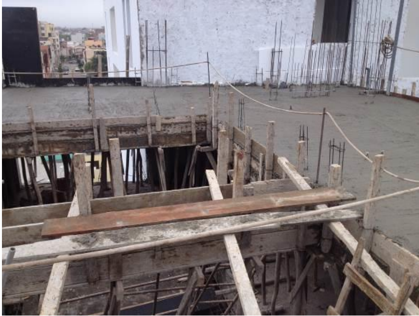
Se observa colado de concreto de losa del 6to nivel – Bloque B.
