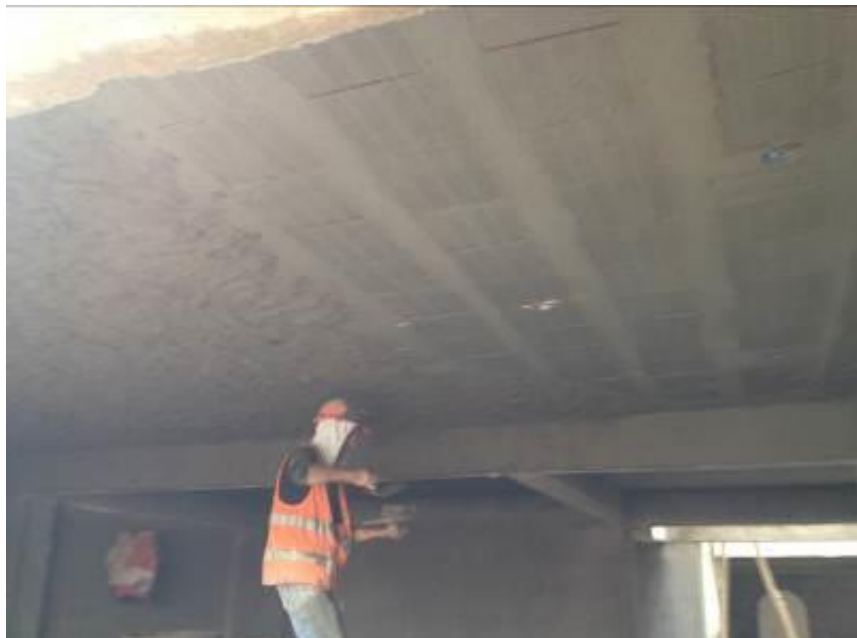
Se observa avance en cielo raso en el 1er y 2do nivel del Bloque B.
