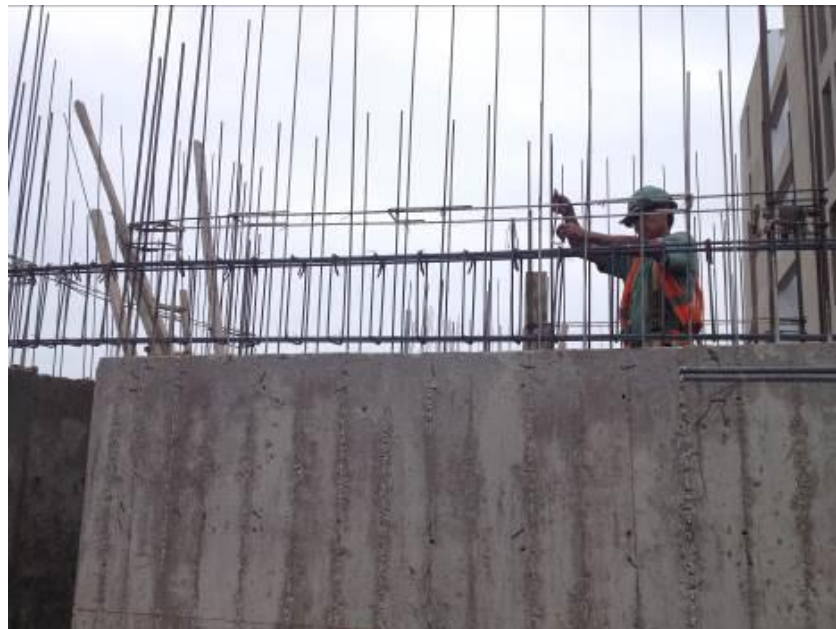
Se observa el habilitado de acero de vigas de techo del 2do nivel.
