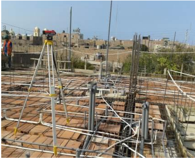
Se observa armado de techo del 3er nivel – Bloque Posterior.
