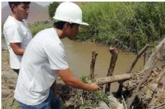
Imagen 6–Perspectiva – Toma de medidas – Bocatoma Fuente: Autoría Propia
