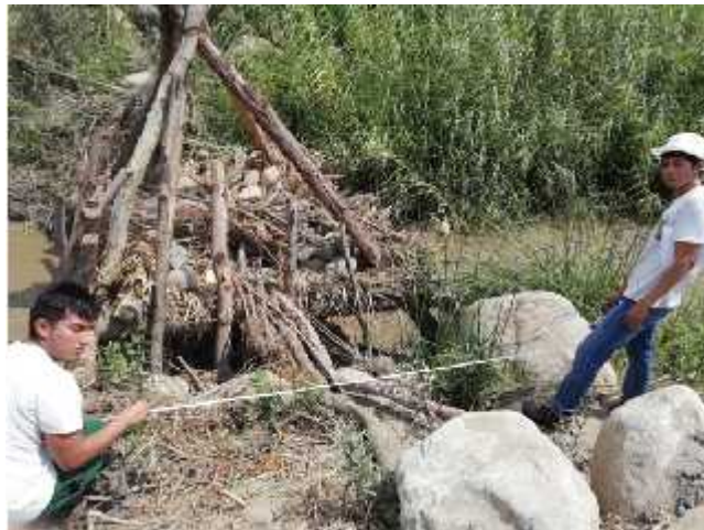
Imagen 8 –Perspectiva – Toma de medidas – Bocatoma Fuente: Autoría Propia
