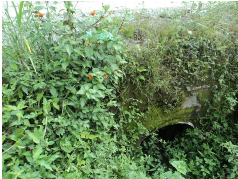
Fotografía 2: Alcantarilla en el Km. 17+234.
